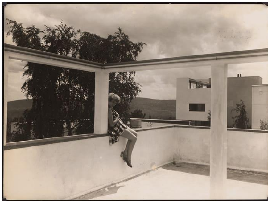
Figura 06: Terraço da Casa Poelzig, Weissenhofsiedlung, Estugarda, Dr. Otto Lossen, 1927. Fonte: Architekturmuseum TU Berlin/ Weissenhofmuseum im Haus Le Corbusier.
