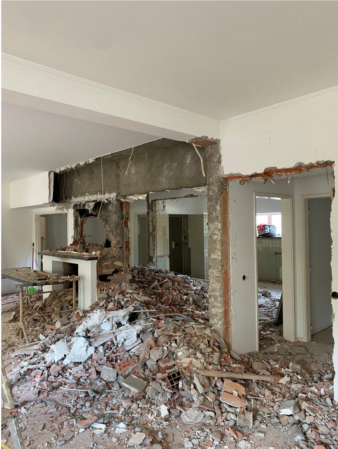
Remodelação de apartamento, projecto de Fernando Hipólito, 2023/2024 (intervenção numa fracção de edifício existente de habitação colectiva em Cascais, da autoria de Arqtº Gil Graça, 1969) - antes
