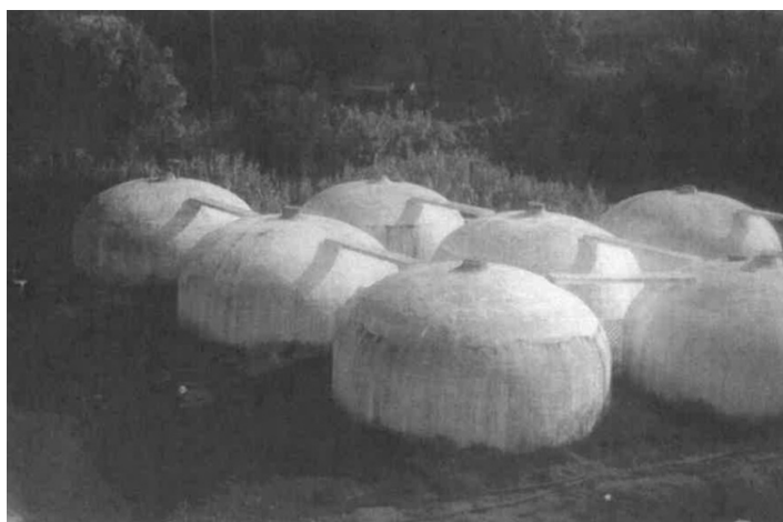
Figura 4.12: Depósitos de vinho da Adega Cooperativa de Dois Portos
