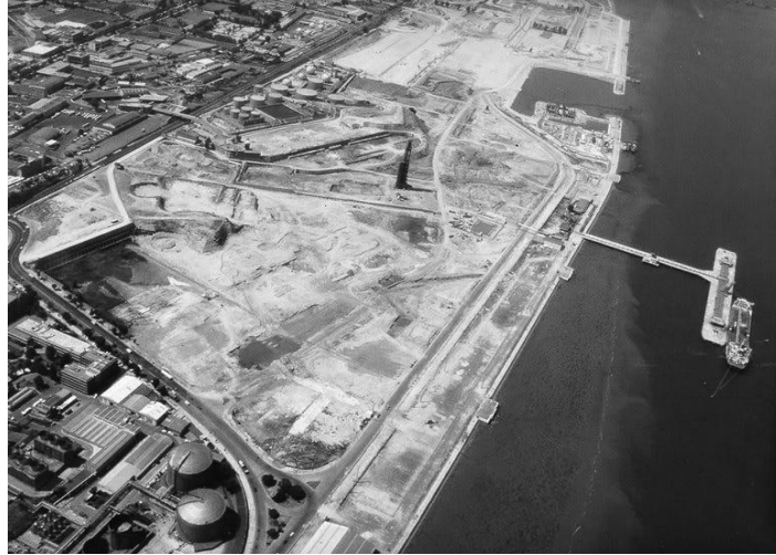
Imagem 26 | Fotografia da zona da EXPO, no início das obras, disponível em: http://www.skyscrapercity.com/
