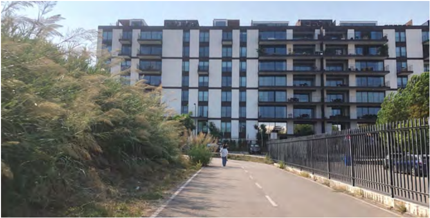
Figura 434 - Vista do local de intervenção a poente, do lado direito a Escola Básica Quinta de Marrocos, de frente para a rua Fernanda Botelho.
