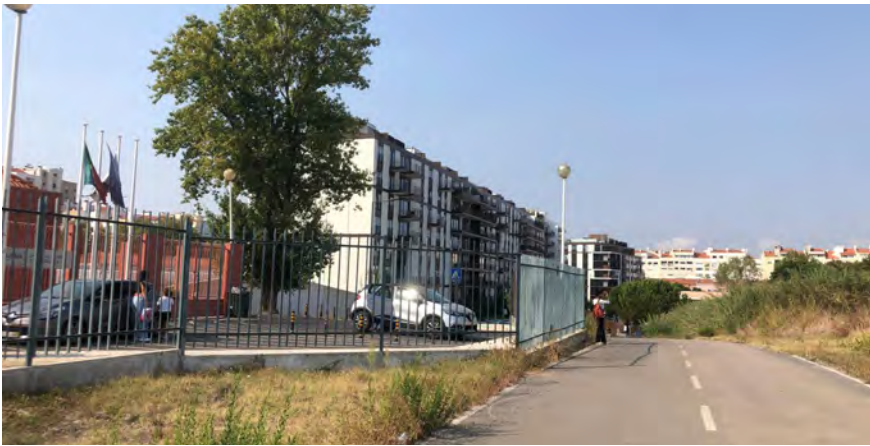
Figura 442 - Vista do local de intervenção a sul. Estrada paralela à rua Fernanda Botelho e relação com o Jardim de Infância nº1 de Benfica.
