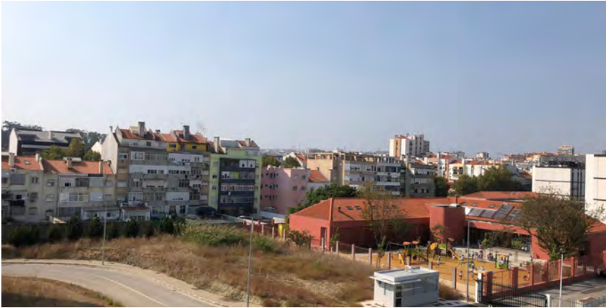
Figura 436 - Vista do local de intervenção, da cota mais alta do terreno, junto à Escola Superior de Música de Lisboa, para o Jardim de Infância nº1 de Benfica.
