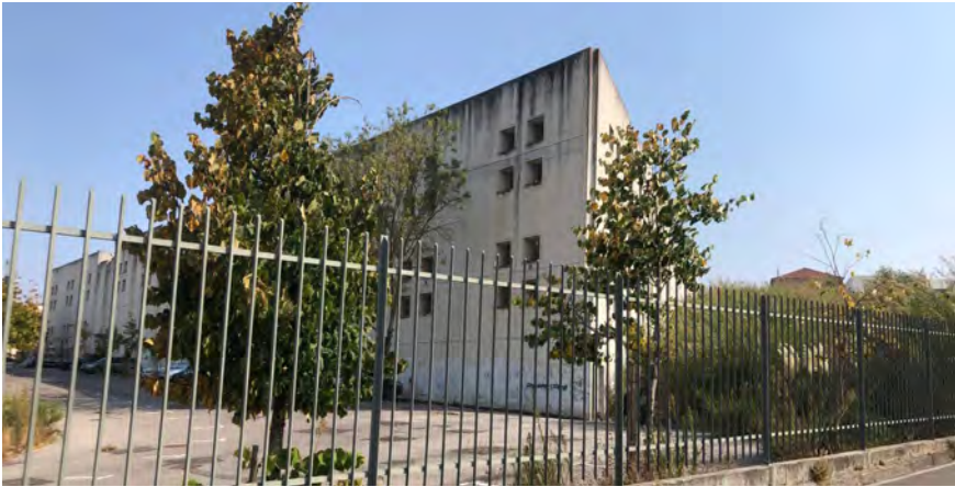
Figura 441 - Escola Secundária José Gomes Ferreira. Gradeamento à volta do local de intervenção.
