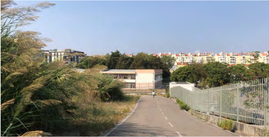
Figura 440 - EVista do local de intervenção a sul. Estrada de acesso ao estacionamento da Escola Superior de Música de Lisboa. Escola Básica quinta de Marrocos.
