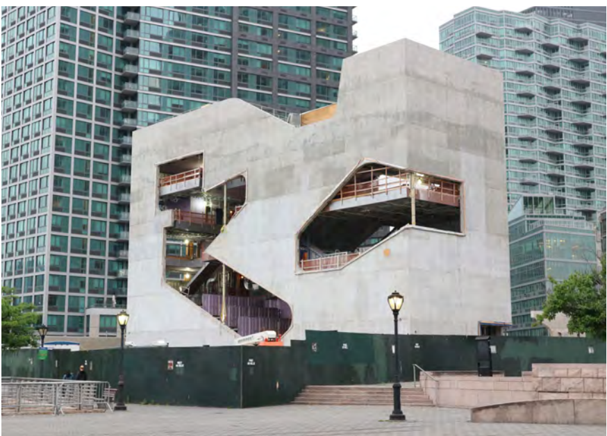
Figura 353 - Fotografia do exterior da biblioteca em construção.
