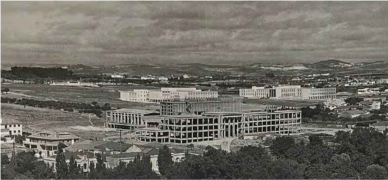
Figura 91 - Vista geral da estrutura.
