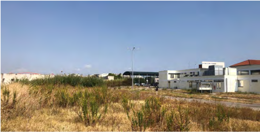
Figura 437 - Vista do local de intervenção a nordeste. Edifício de Serviços de apoio do Instituto Politécnico de Lisboa.
