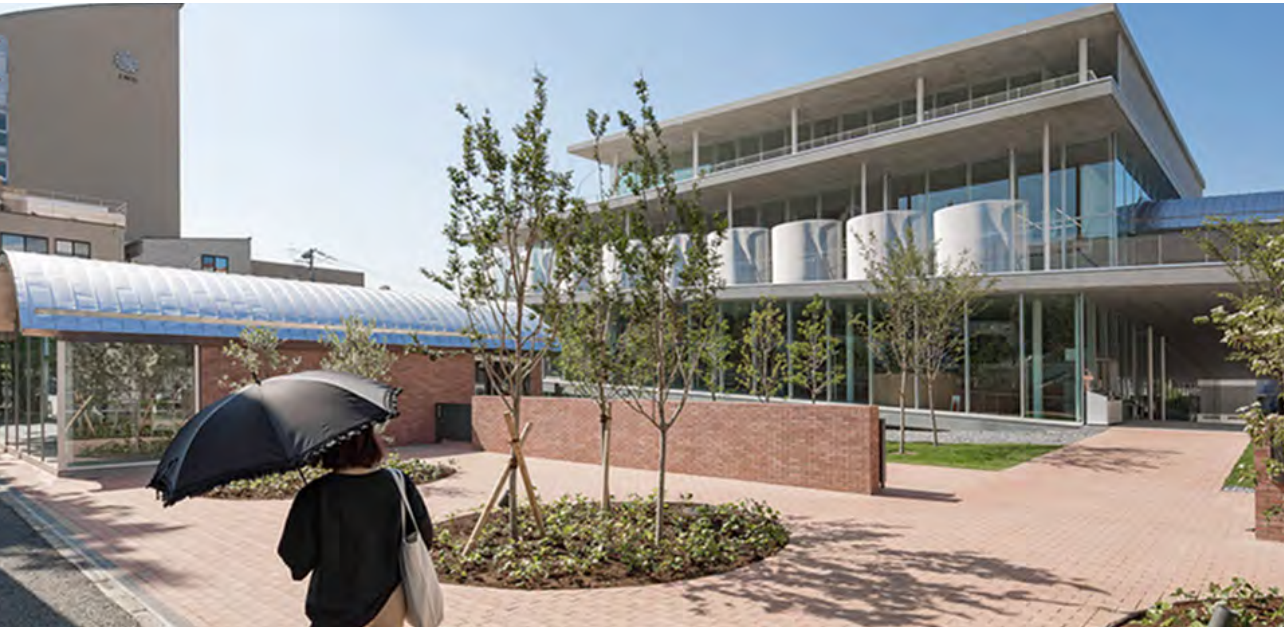
Figura 362 - Vista da fachada principal. © Vincent Hecht
