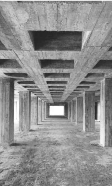
Figura 90 - Estrutura portante do edifício.
