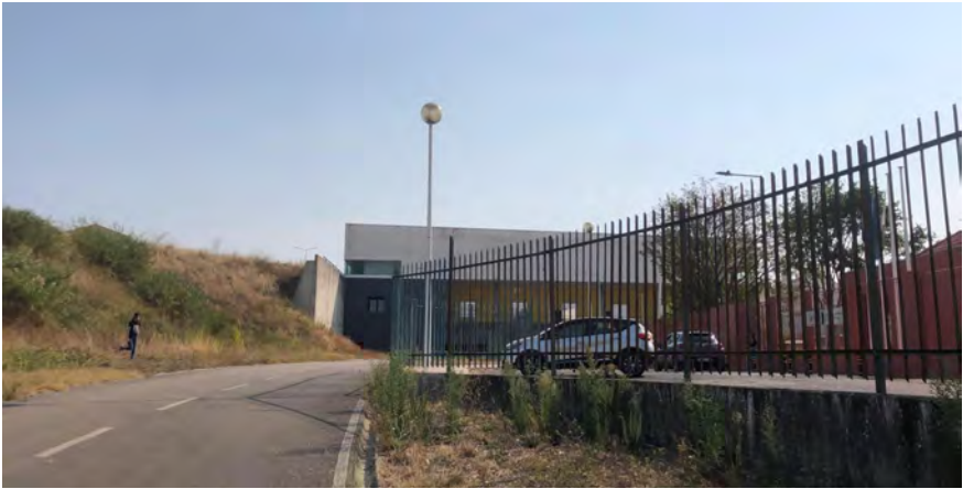
Figura 433 - Vista do local de intervenção a sul. Escola Superior de Música de Lisboa.
