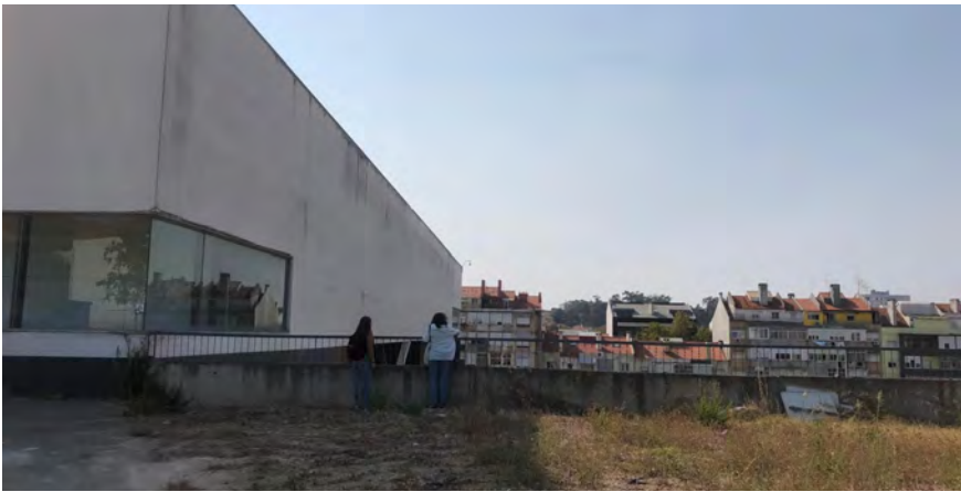
Figura 439 - Vista do local de intervenção a poente. Escola Superior de Música de Lisboa.
