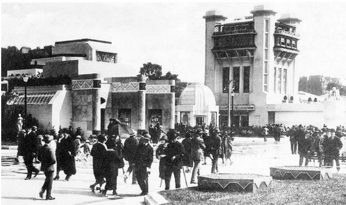
Figura 59: Dois aspectos da Exposition des Arts Décoratifs et Industriels Modernes, realizada em 1925 em Paris. Em cima, Porta da Concórdia, de Pierre Patou. Em baixo, vários pavilhões, expressão de outros tantos experimentalismos (Cabanne, 1986, p. 57).
