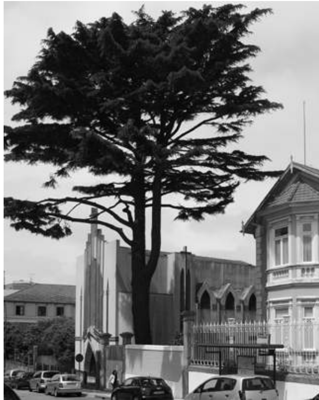
Figura 137: Vista exterior da Capela de N.ª S.ª de Fátima, Porto, de “Ars Architectos”.
