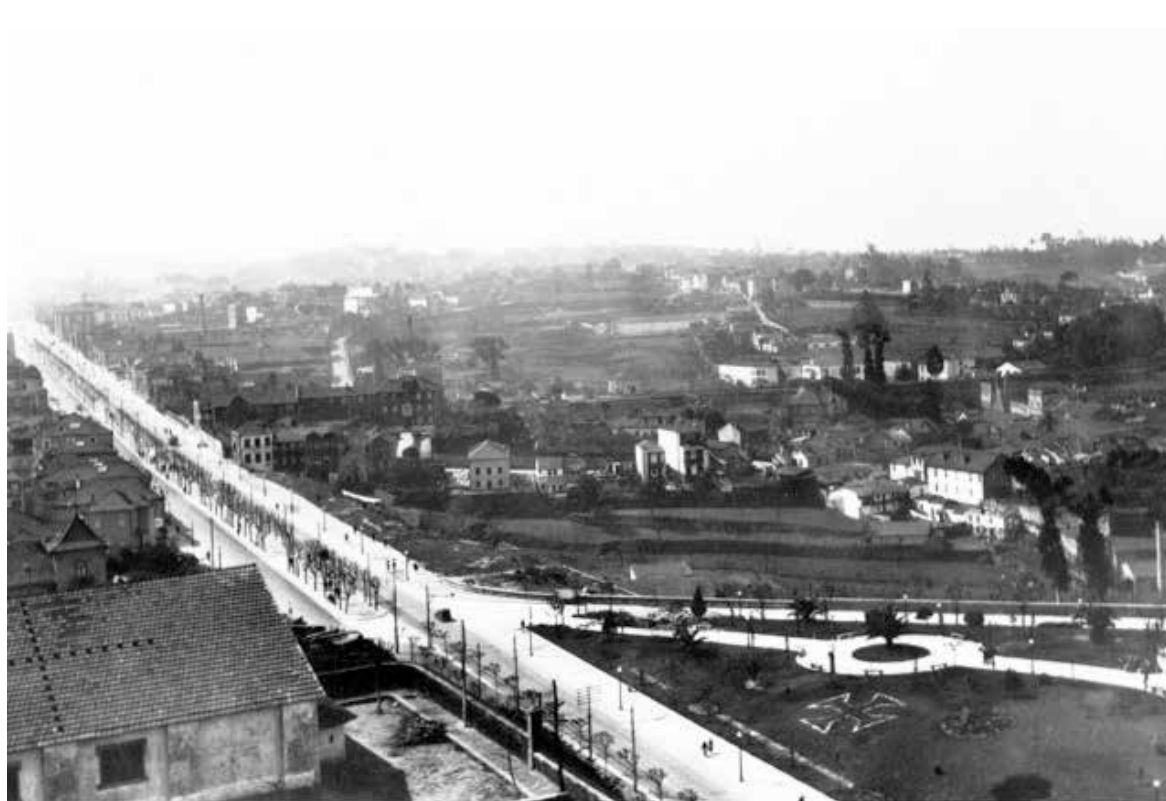
Figura 114: A Av. da República em Gaia, vista da Serra do Pilar, cerca de 1934. O Jardim do Morro situa-se à direita na imagem. Bilhete-postal ilustrado.
