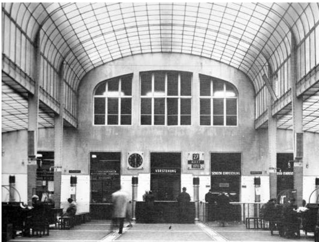
Figura 40: Otto Wagner: Edifício para a Caixa Postal de Viena, 1904. Vista da sala. A estrutura de metal e vidro da Caixa Postal não é usada exclusivamente por razões práticas, mas pelo modo lógico como adequa essas razões às qualidades estéticas pretendida (Russel, 1983, p. 257).
