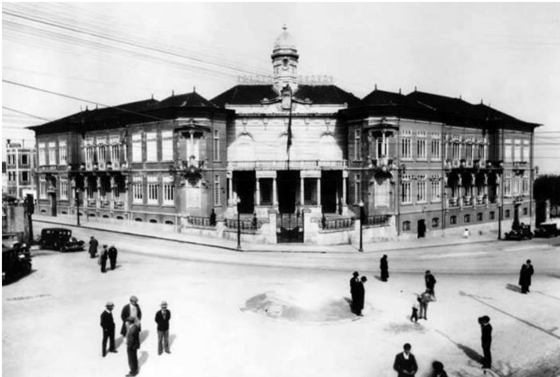
Figura 115: Vista sul do edifício dos Paços do Concelho de Gaia, projectado em 1916 pelo arquitecto Francisco de Oliveira Ferreira, na confluência da Av da República com a R. de Álvares Cabral, cerca de 1930. O terreno do concurso para o MBG situa-se à direita na imagem. Bilhete-postal ilustrado.
