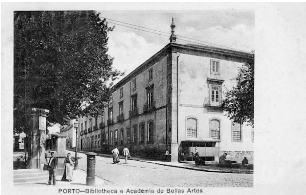
Figura 81: Bilhete-postal segunda década do séc. XX, com imagem do lado nascente do Jardim de S. Lázaro, com o edifício que, em 1929, albergava tanto a BPPM como a EBAP (Fonte: Cp).
