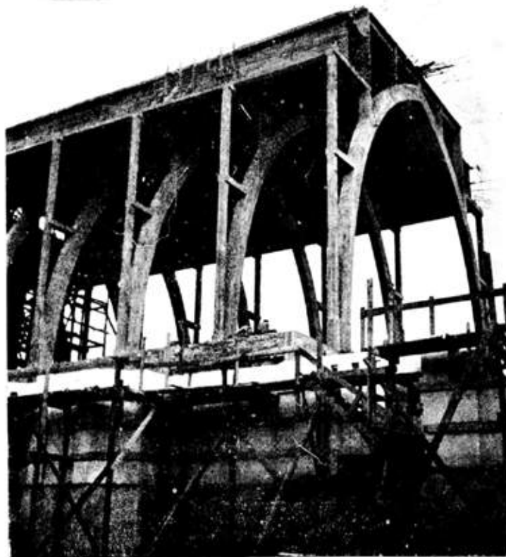
Um aspecto da construção
