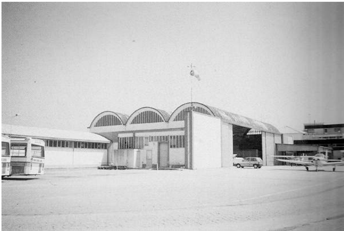
Figura 173: Francisco Correia de Araújo: estrutura para um hangar de três abóbadas delgadas contínuas, no aeroporto de Pedras Rubras (Viseu, 1993 p. 58)
