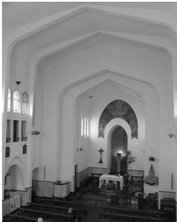
Figura 138: Vista interior da Capela de N.ª S.ª de Fátima, Porto, de “Ars Architectos”.
