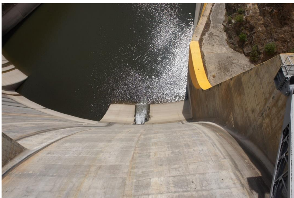
Figura 110 Soleira do descarregador, barragem de Bemposta, 2014, fotografia da autora.
