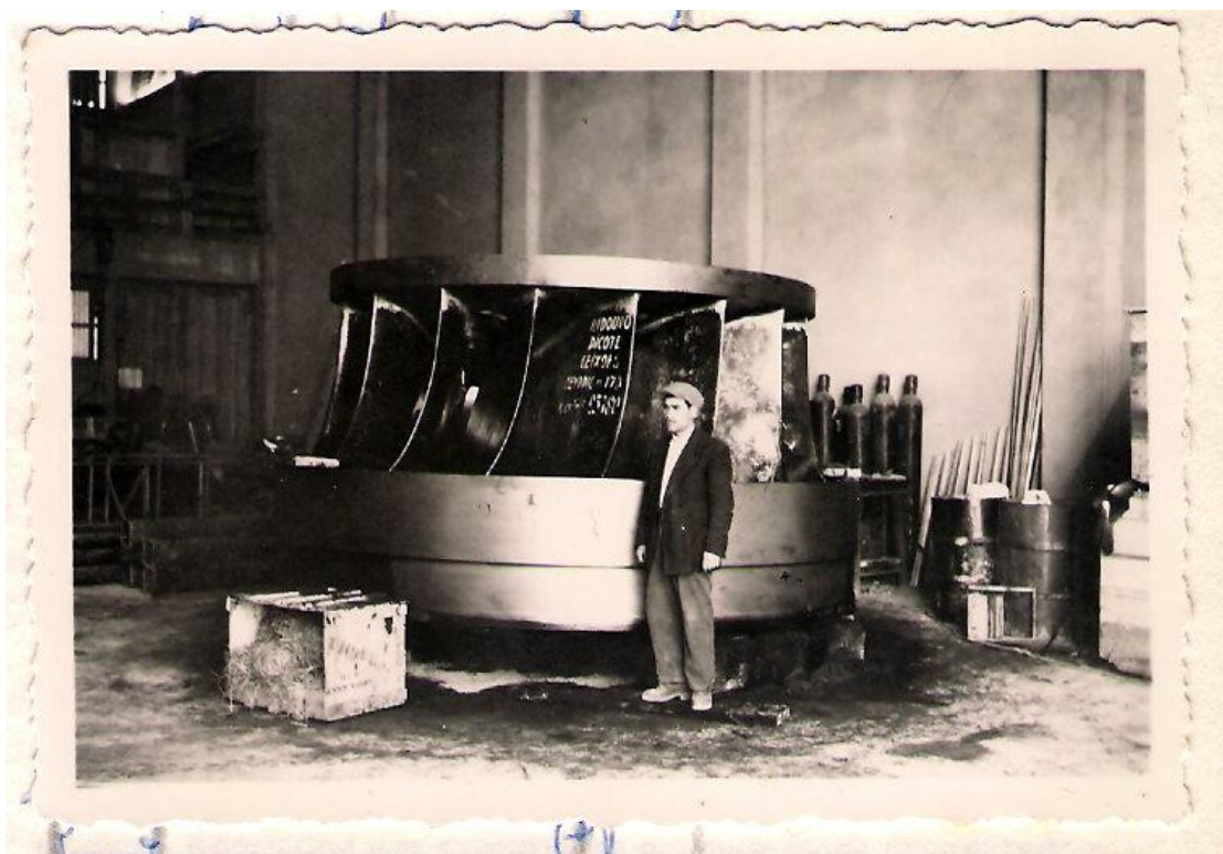
Figura 29 Fotografia cedida pelo engenheiro Pereira dos Santos.
