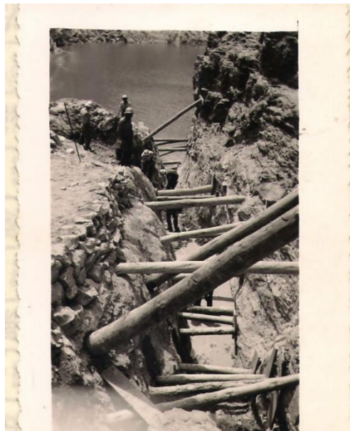
Figura 27 Construção da barragem do Carrapatelo, fotografia cedida pelo engenheiro Pereira dos Santos.
