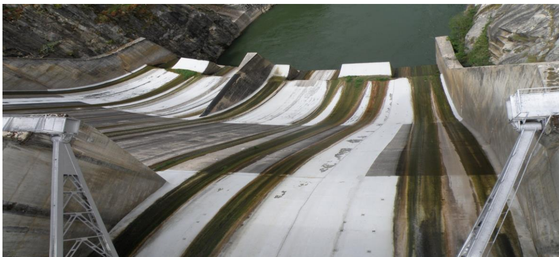
Figura 30 Na barragem: contrafortes e soleira do descarregador, 2009. Fotografia da autora.
