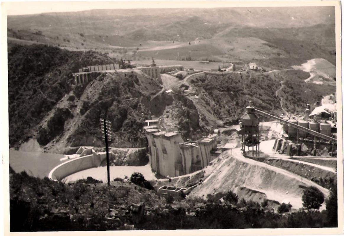
Figura 25 Construção da barragem de Picote. Fotografia cedida pelo engenheiro Pereira dos Santos.
