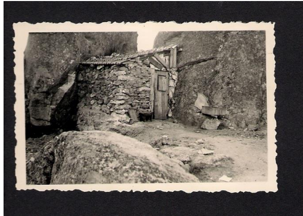
Figura 37 Casa de família. Relatório de 1956 cedido pelo engenheiro Pereira dos Santos.
