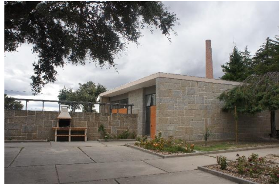
Figura 71 Pormenor do centro comercial (zona da padaria) agora com uma chaminé para churrascos. Barrocal, 2014, fotografia da autora.
