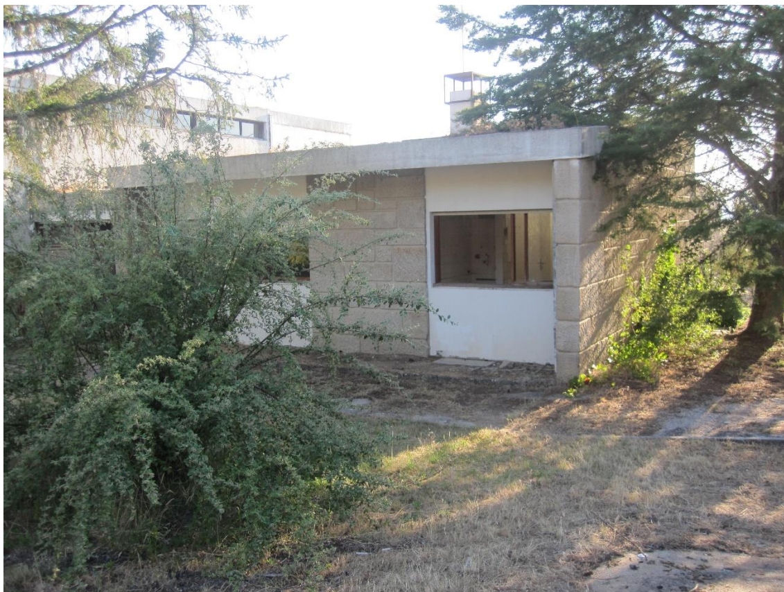
Figura 67 Casas dos engenheiros e pessoal dirigente, abandonadas. Fotografia da autora.
