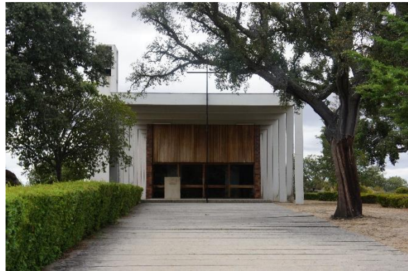
Figura 70 Vista da capela. Barrocal, 2014. Fotografia da autora.
