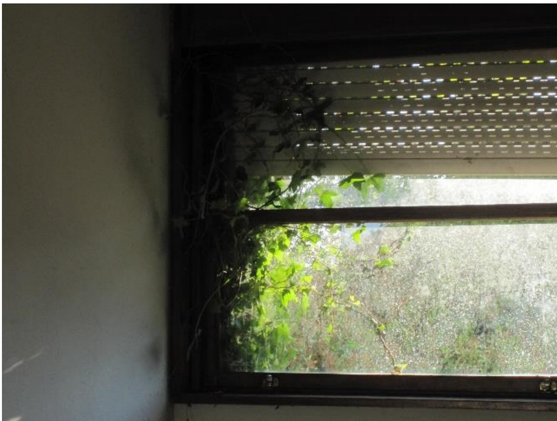
Figura 63 Janela de uma casa fotografada em agosto de 2013, interior de uma sala.
