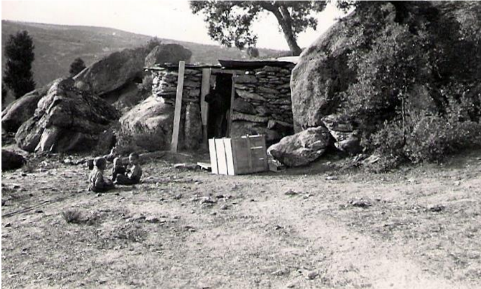
Figura 52 Abrigo de família, relatório de 1956, cedido pelo engenheiro Pereira dos Santos.
