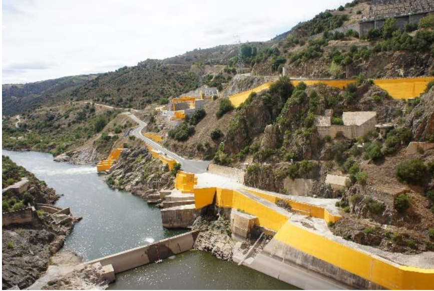
Figura 109 Barragem de Bemposta, 2014, fotografia da autora.
