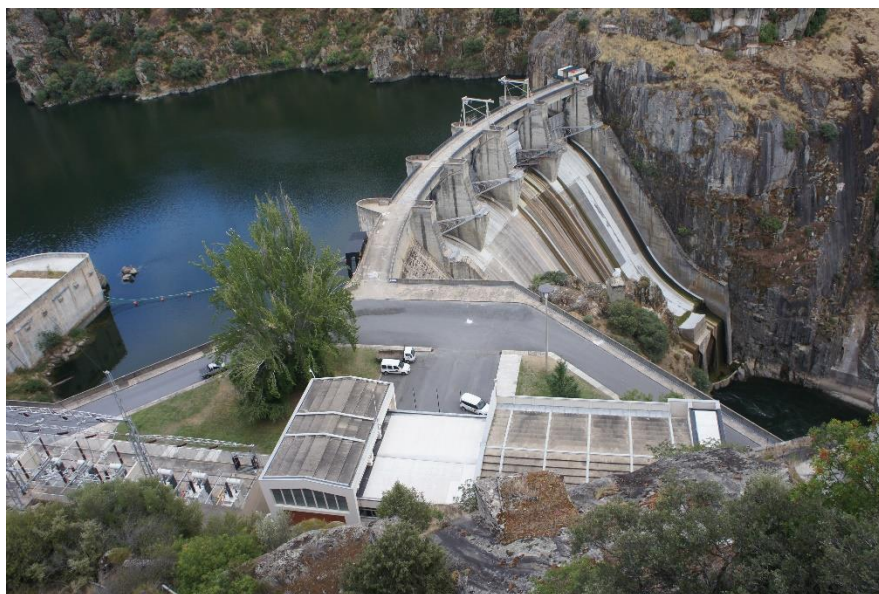
Figura 10 Barragem de Picote, 2014, fotografia da autora.
