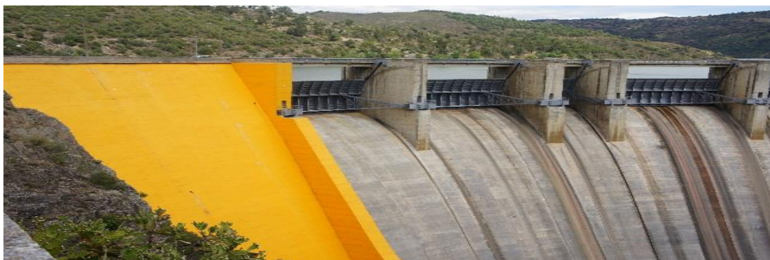
Figura 60 Barragem de Bemposta, 2014. Fotografia da autora.
