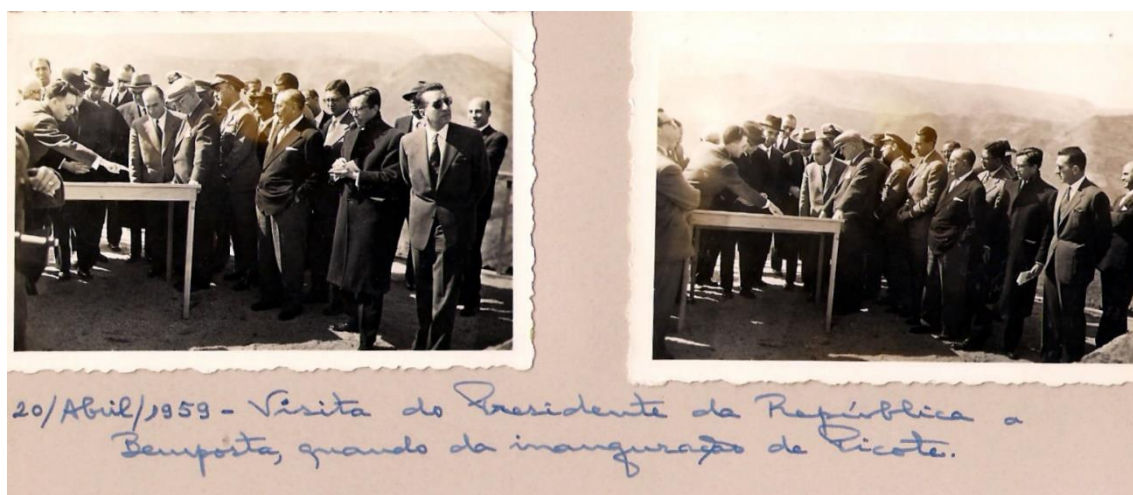
Figura 28 Fotografia cedida pelo engenheiro Pereira dos Santos.
