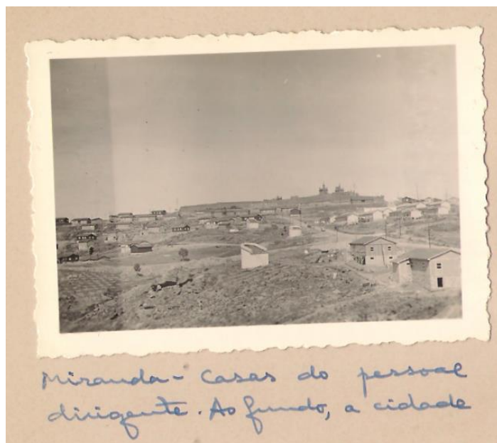
Figura 32 Fotografia cedida pelo engenheiro Pereira dos Santos.
