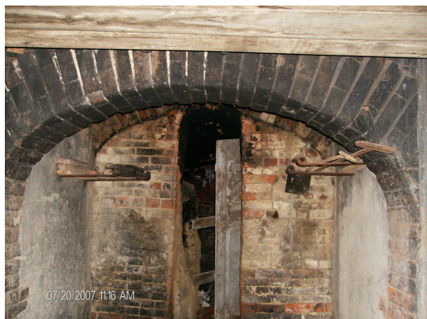
Ilustração 33- Interior de um forno desactivado (à esquerda), fornalha e caldeira (à direita)
