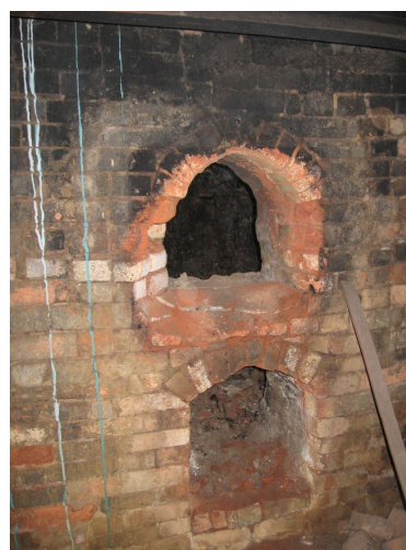
Ilustração 33- Interior de um forno desactivado (à esquerda), fornalha e caldeira (à direita)
