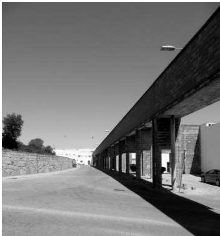
Fig. 07 - Bairro da Malagueira . Conduto (sector Oeste)
