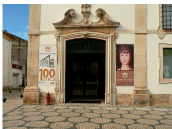
Figuras 342 e 343 • Edifício do museu; entrada do museu.
