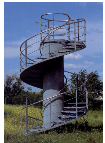
Figura 10 • Plataforma de Observação do Povoado Pré-histórico de Santa Vitória (Campo Maior).
