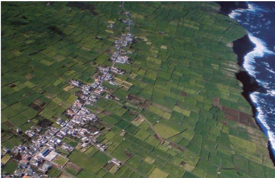
Figura 1. Vista aérea do caminho paralelo ao mar, ilha Terceira, Açores 7
