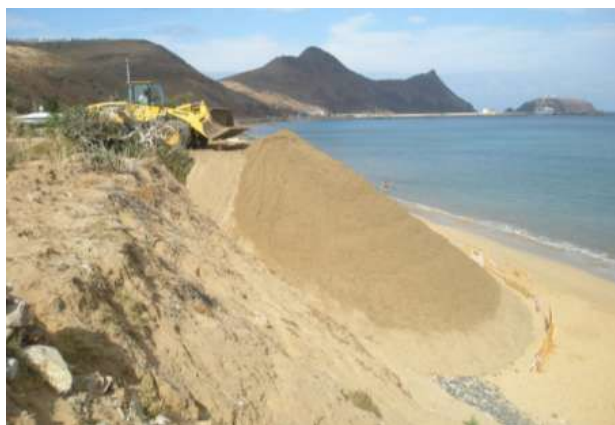
Figura 4 - Recarga artificial da praia do Porto Santo em 21 de Julho de 2008 (Fonte: Andrade et al., 2011)
