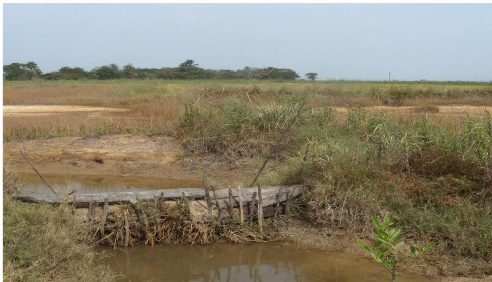
**Figura 10:** Dique, impede que a água salgada entre para a bolanha<sup>61</sup>
