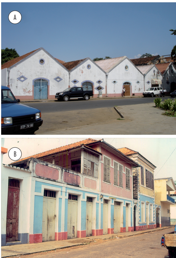
Figura 1 - Conjunto de quarteirões situados na actual baixa da cidade de São Tomé, construídos no período colonial.
