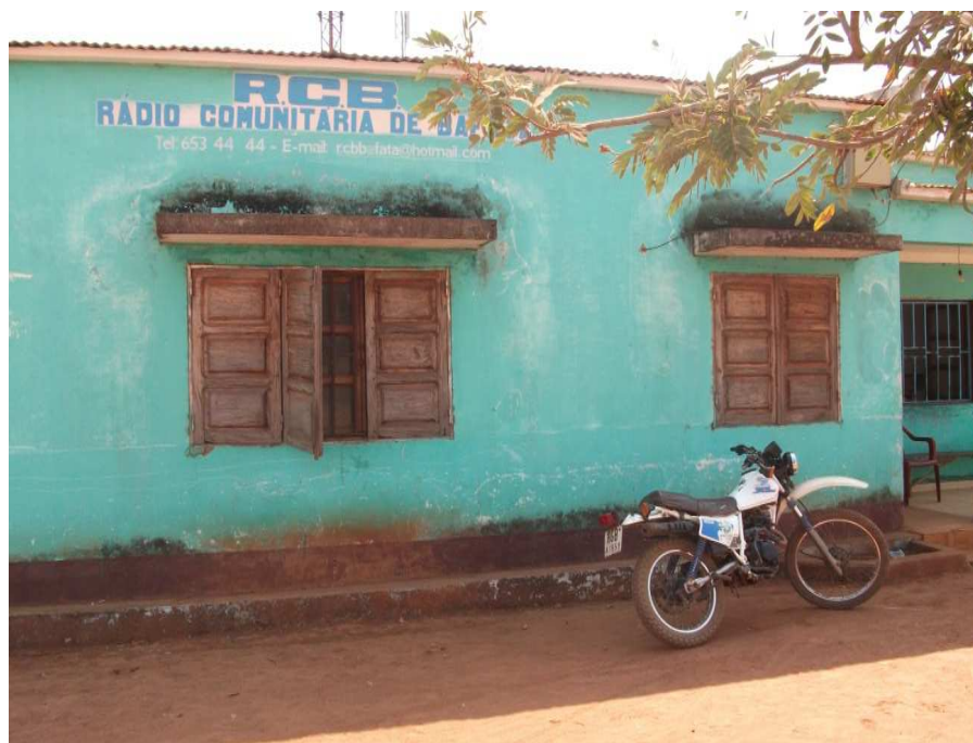
Figura 9: Instalação de RCB
