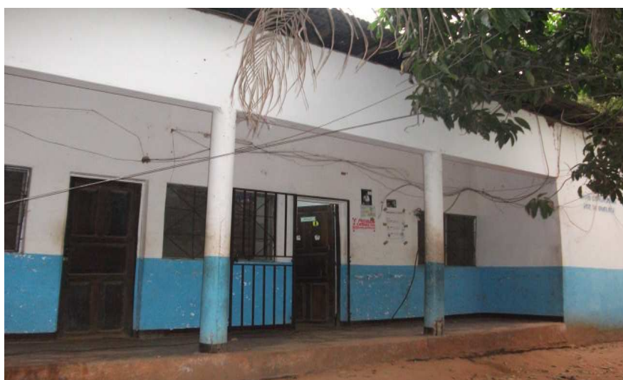
Figura 1: Instalação da RVQ
