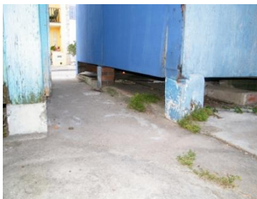
28. Escaroupim. Pilares em alvenaria de tijolo.
