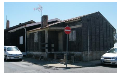
22. Palheiro na Tocha. Exemplo com os dois tipos de revestimento mostrados em baixo.
