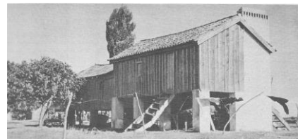
25. Inquérito: Quinta do Alqueidão, Porto da Palha, Azambuja. Exemplo de estacaria de troncos de árvore e exemplo de estacaria de tijolo com reboco.
