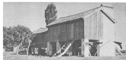
25. Inquérito: Quinta do Alqueidão, Porto da Palha, Azambuja. Exemplo de estacaria de troncos de árvore e exemplo de estacaria de tijolo com reboco.
