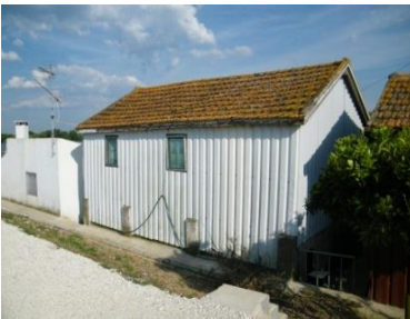
27. Aldeia do Lezirão. Chapa ondulada que deixa à vista os pilares de betão.
