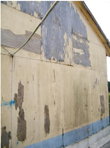
26. Escaroupim. Contraplacado de madeira.
