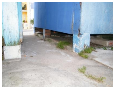
28. Escarpim. Pilares em alvenaria de tijolo.
