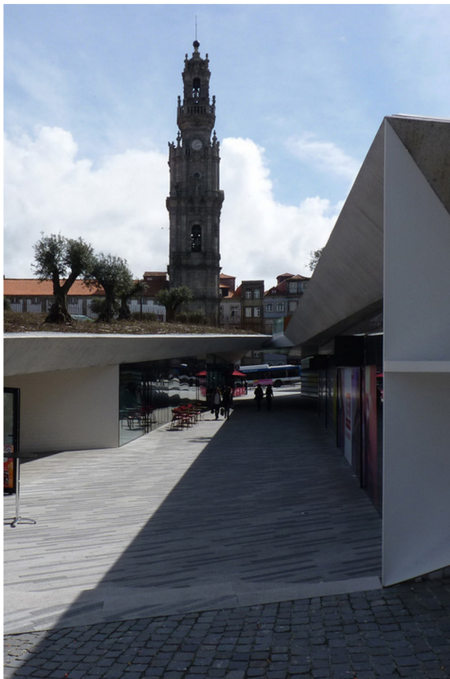
Fotografia da Praça de Lisboa no Porto, estrutura arquitectónica que suporta a praça e que ao mesmo tempo a rasga para permitir um percurso subterrâneo que liga com a cidade. Projecto de Pedro Balonas do atelier Balonas & Menano. Fotografia de Ana Pina.
