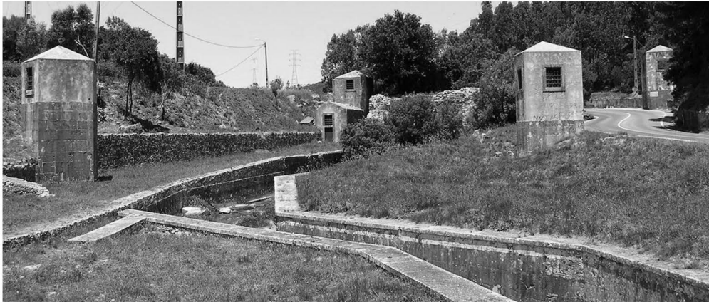
respiradores do aqueduto das águas livres casa ^ ^ ^
