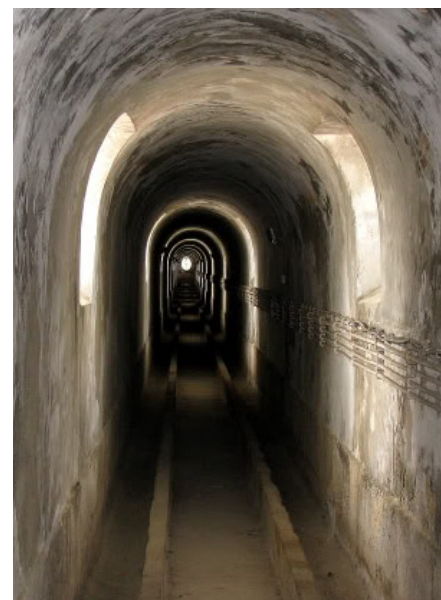
07. Vista do interior do aqueduto das águas livres.
