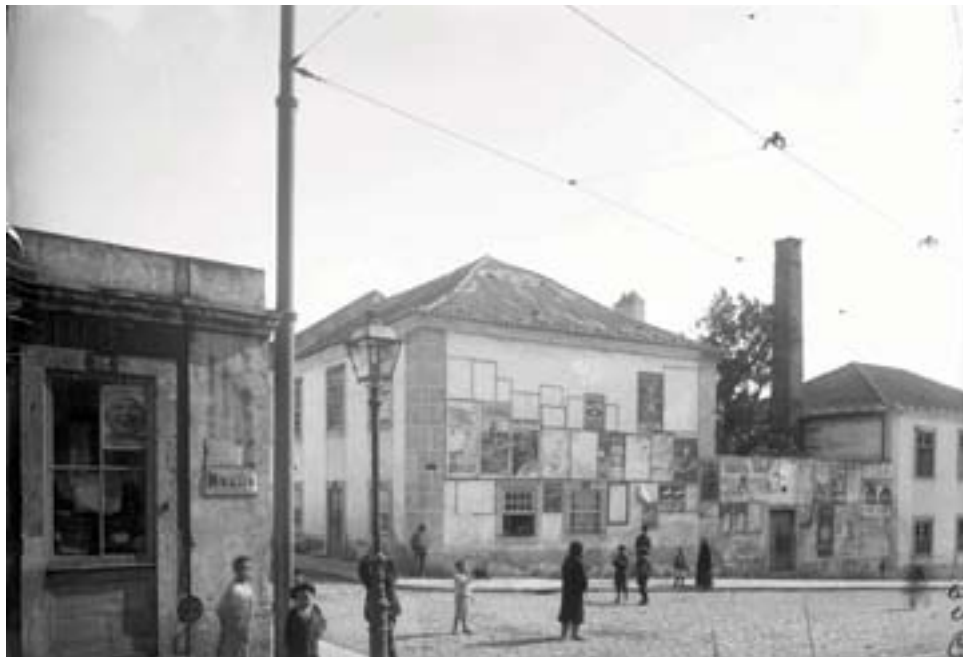
Rua das Amoreiras [entre 1898 e 1908]; Fonte: Arquivo Municipal de Lisboa
