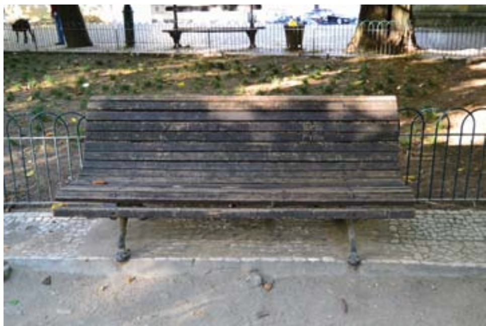
Banco em madeira e ferro forjado, a manter
