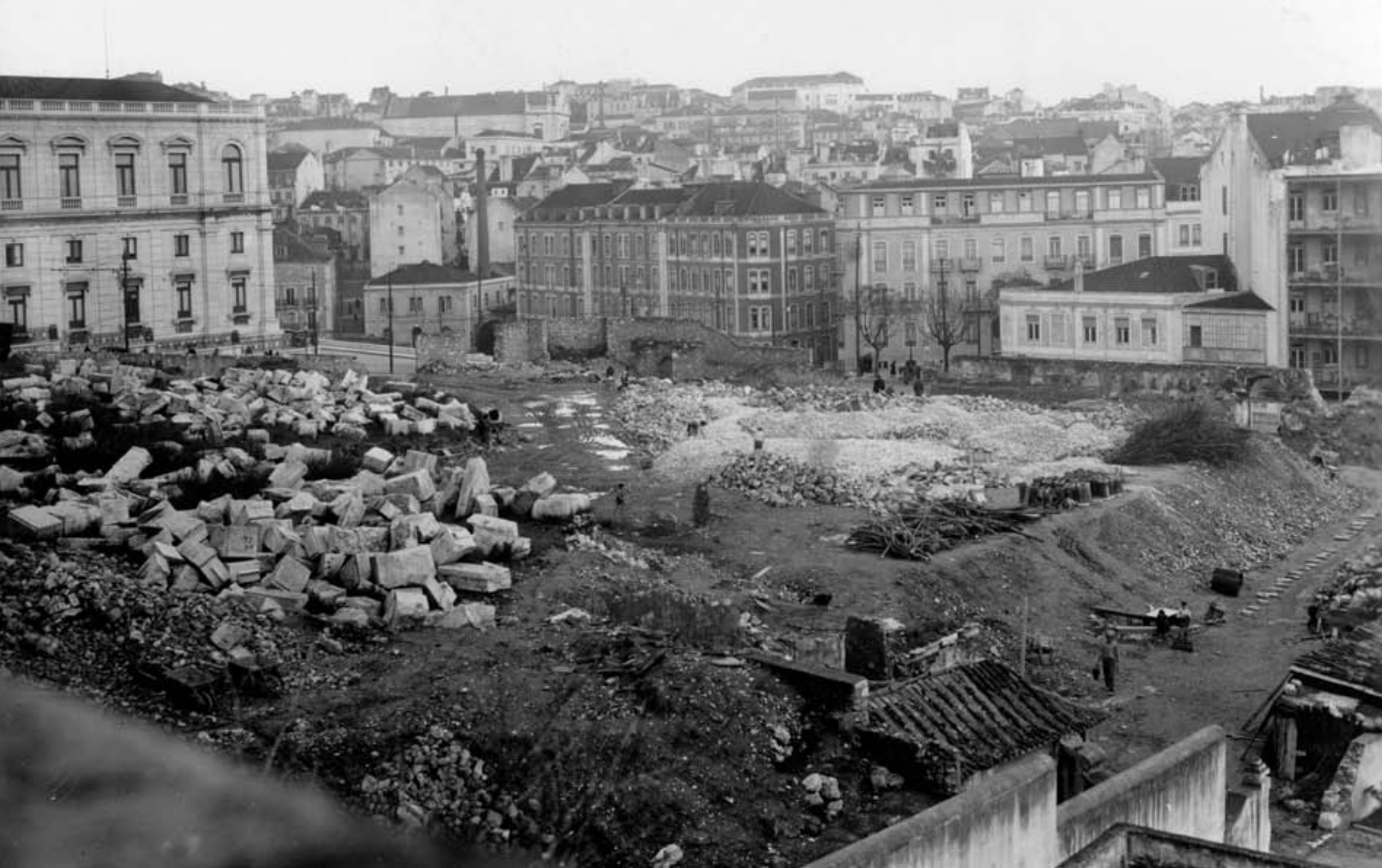
Figura 3: Pedras provenientes da demolição do Arco de São Bento colocadas no terreno onde foi o Convento das Francesinhas [entre 1900 e 1958; Fonte: Arquivo Municipal de Lisboa, PT/AMLSB/POR/060083]
