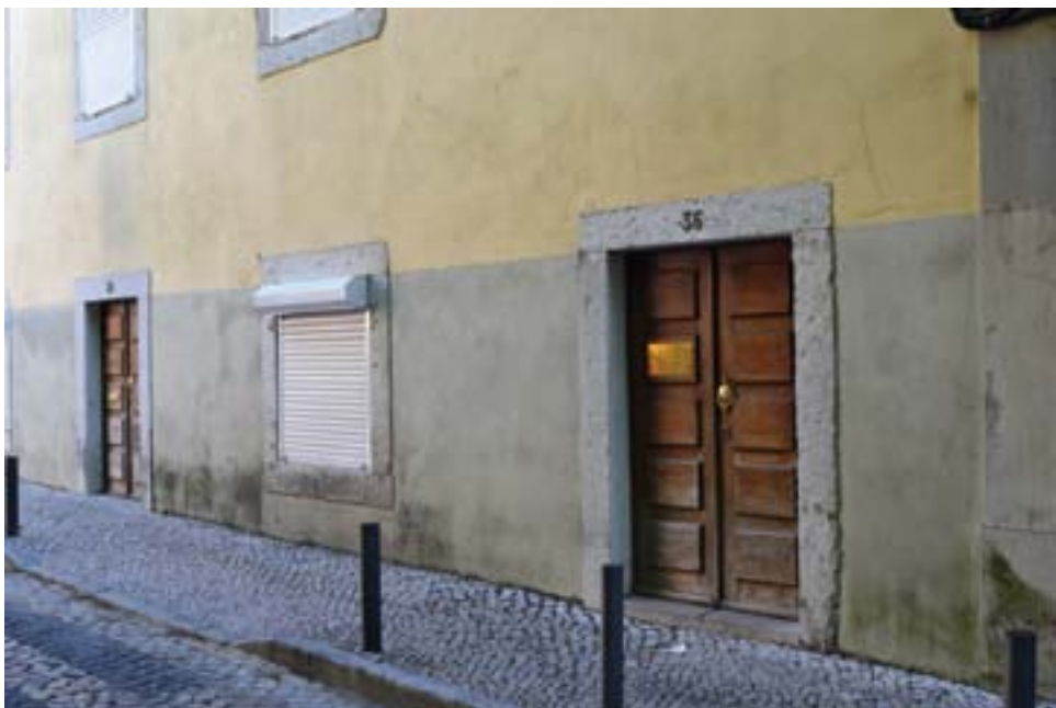
Rodapé de fachada m existente na maioria dos edifícios que limitam a Praça das Amoreiras
