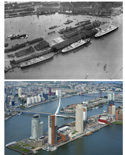
Figura 16 e 17 – Fotografias de antes e depois da intervenção urbana em Wilhelminapier
