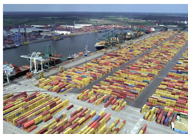
Fig 4- Vista geral porto de contentores Antuérpia, Bélgica
