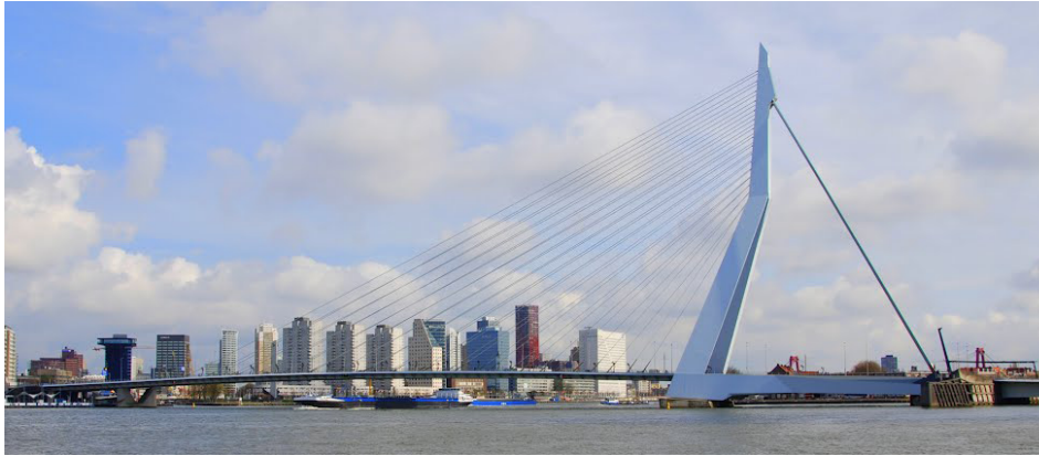
Figura 18 – Fotografia da ponte Erasmus
