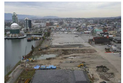
Fig 7- Vista aérea de um “brownfield” em Vancouver, Canadá
