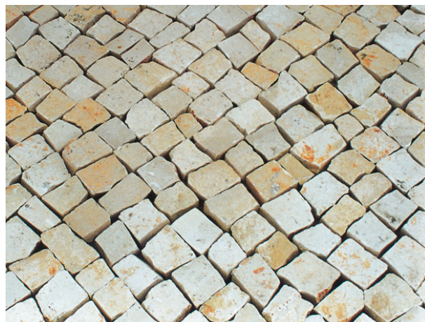
pavimento existente(miicro cubos de calcário)
