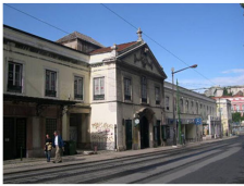
Convento das Trinas do Rato Real Fábrica das Sedas
