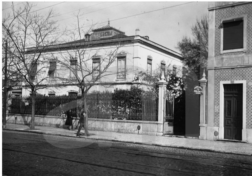
Edifício na Rua Professor Sousa da Câmara demolido para abertura da Rua Plácido de Abreu , Disponível no Arquivo Fotográfico de Lisboa e em < http://arquivomunicipal.cm-lisboa.pt/default.asp?s=12079 >
