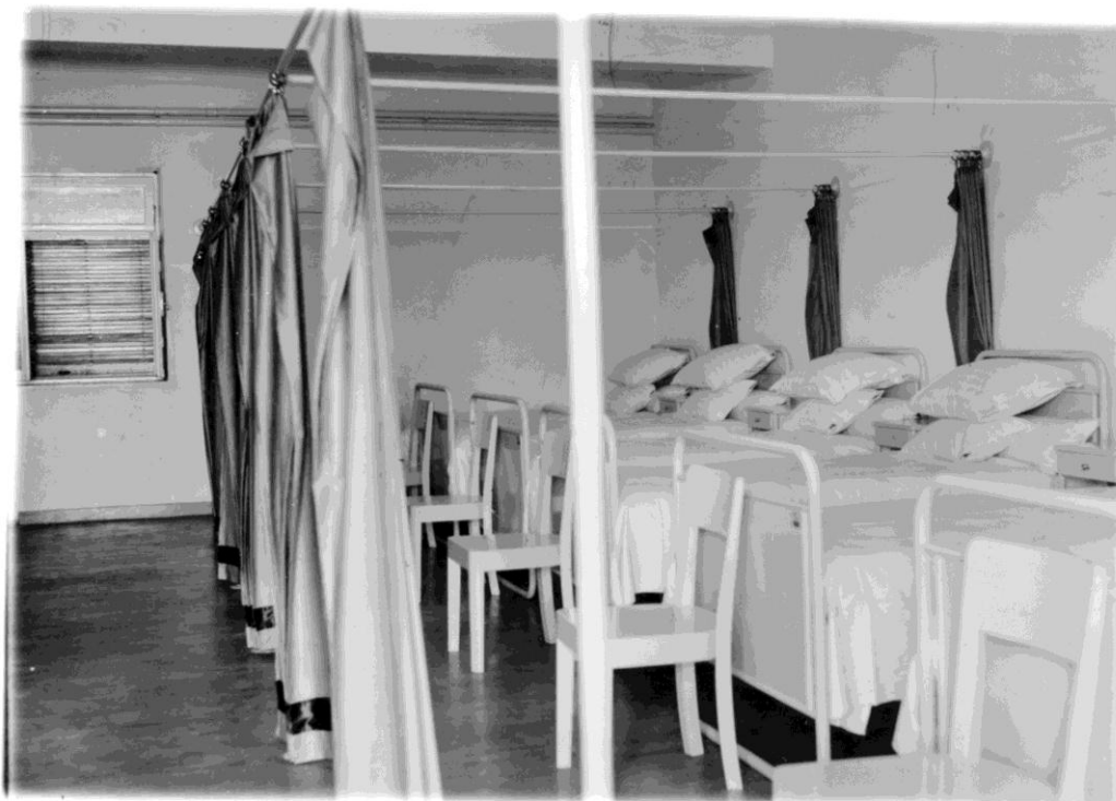
Enfermaria do Hospital de Albergaria-a-Velha.
