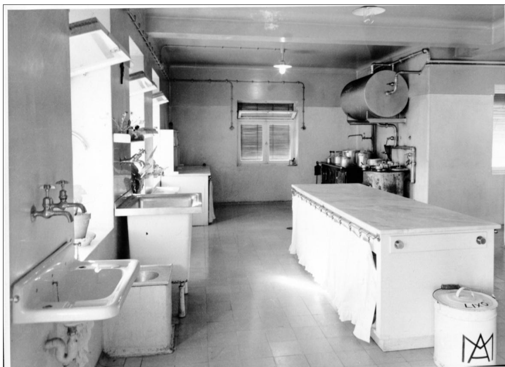
Cozinha do Hospital de Albergaria-a-Velha.
