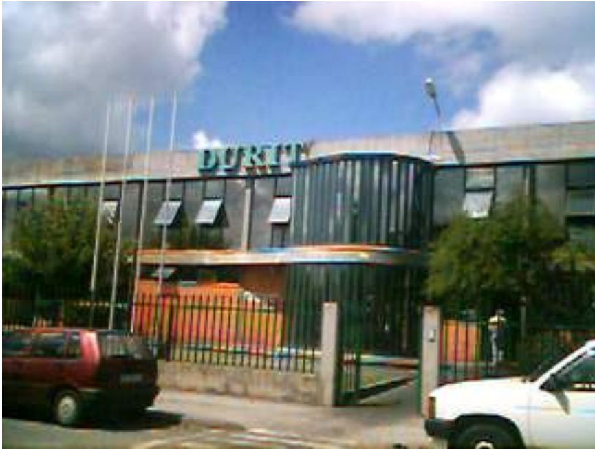
Edifício Principal da Empresa.
