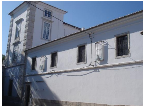
Fig.C2. 12 - Parede nascente, vista pelo exterior
