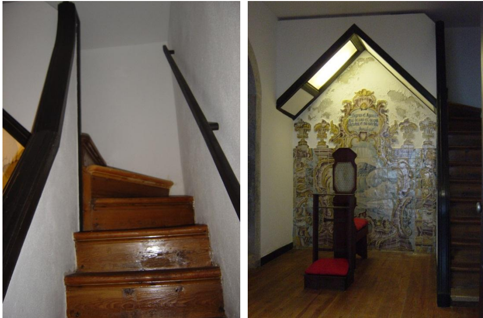
Fig.C2. 21 - Escada interrompida na sacristia, situada no torreão ponte, junto à capela.
