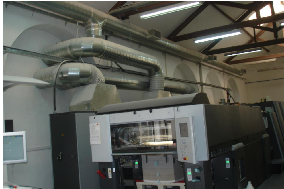
Fig. C1. 15 – Aspecto parcial da arcada;
