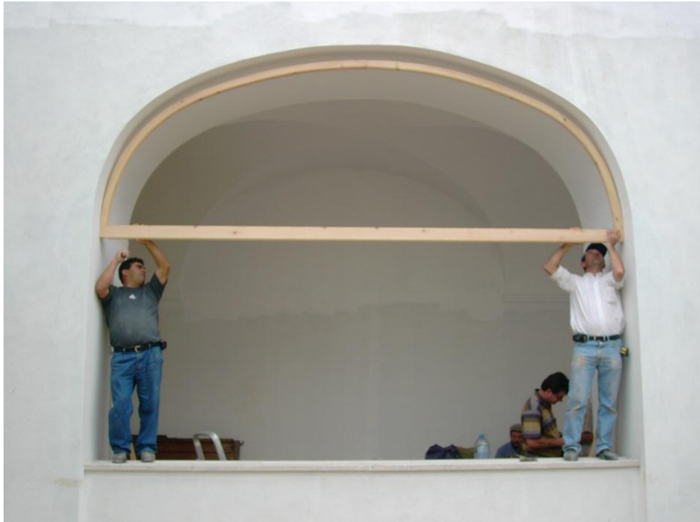
Fig. C1. 40 – Arco abatido do claustro do palácio. Fotografia de F. Silva Alves, durante as obras de beneficiação do claustro.
