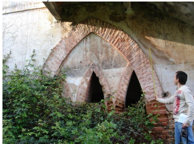
Fig. C4. 32 - Convento S. Francisco – fenestração na fachada da igreja
