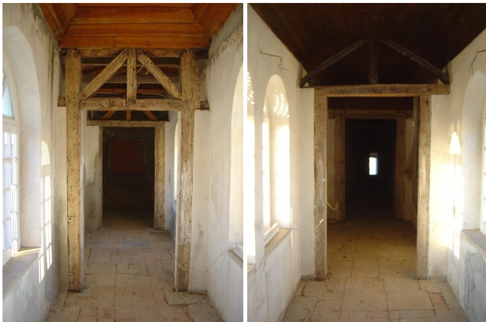
Fig.C2. 9 – Estruturas do mirante
