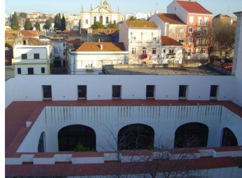
Fig.C2. 13 - Parede nascente, vista pelo interior
