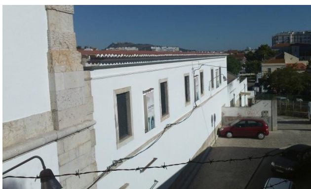
Fig. C1. 25 – Imagem da fachada nascente captada de sul para norte;
