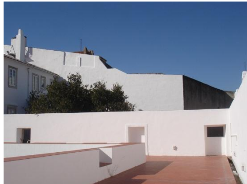
Fig.C2. 14 - Parede poente, vista pelo interior
