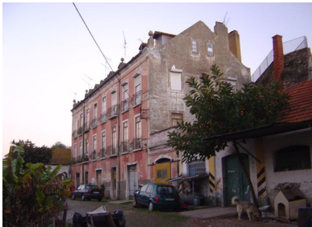
Fig. C3. 13 - Edifício construído no interior do pátio Gago da Silva
