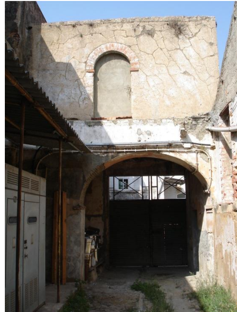
Fig. C1. 189 – Arco abatido no exterior (v6)
