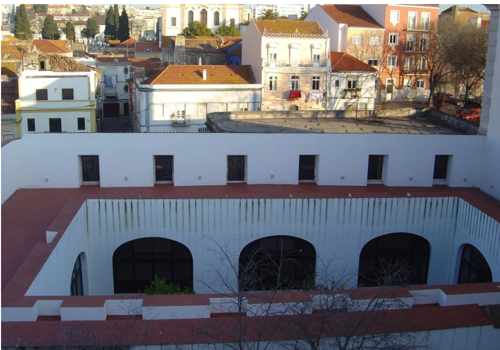
Fig. C3. 31 - Vista O-E sobre o claustro.
