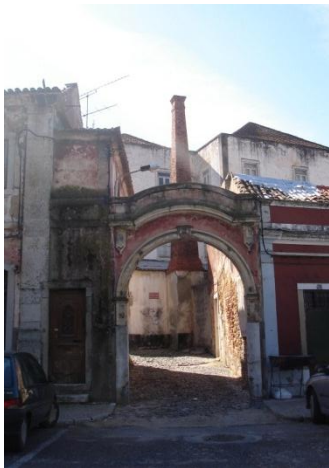
Fig. C3. 12 - Entrada do pátio
