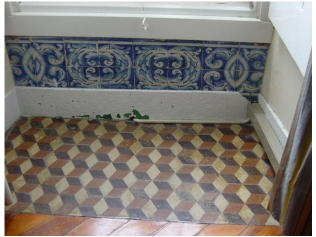
Fig. C4. 34 - Palácio Fryxell - cercadura em azulejo no piso 2
