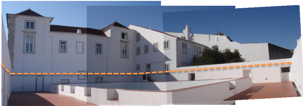
Fig. C4. 13 – Montagem fotográfica do interior do claustro. A laranja, o nível das vergas das janelas das fachadas nascente e poente, e da porta entaipada da parede sul.
