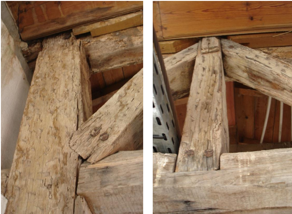
Fig.C2. 10 – Cavilhas de madeira nas uniões das estruturas do mirante
