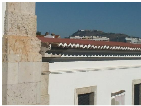
Fig. C2. 16 – Beirado na parede nascente
