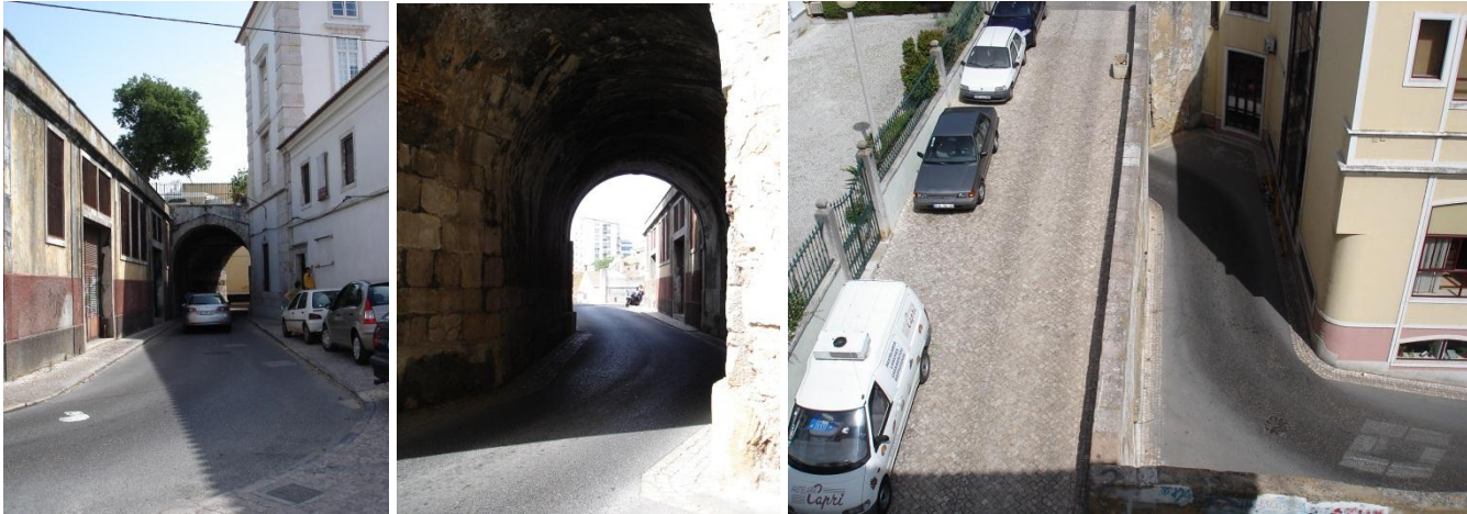
Fig. C3. 25 (à esquerda) - Ponte de S. Sebastião. Vista (N-S) do nível de implantação da ponte; à direita, fachada lateral do edifício em estudo e entrada para o claustro; Fig. C3. 26 (ao centro) - Vista (S-N) da passagem rodoviária por baixo da ponte; Fig. C3. 27 (à direita) Vista (O-E) sobre a plataforma superior da ponte; fotografia tirada a partir do mirante.
