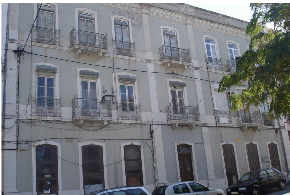
Fig. 3 – Fachada principal do edifício da antiga padaria Santa Maria.
