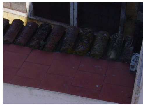
Fig.C2. 17 - Beirado na parede nascente
