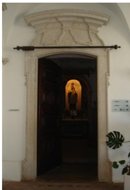
Fig. C4. 45 - Portal em pedra
