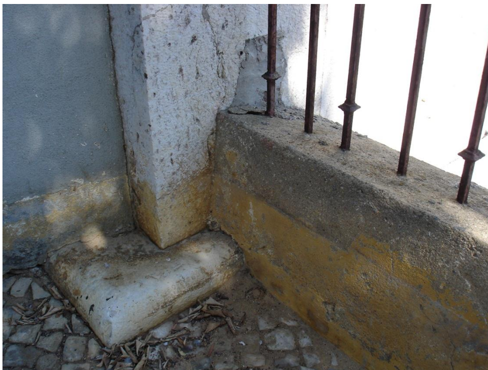
Fig. C4. 22 - Pormenor da pedra que compõe o cunhal e que se prolongaria para baixo.
