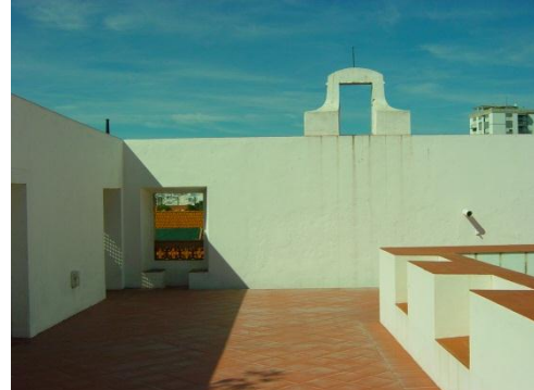
Fig.C2. 15 - Parede norte, vista pelo interior
