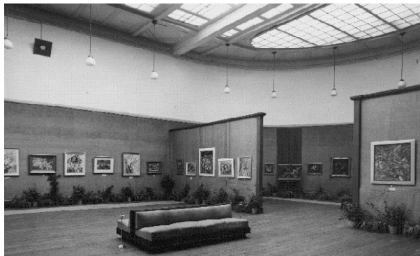
Figura 137 – Sede da Sociedade Nacional de Belas Artes, Rua Barata Salgueiro, n.º 36, Lisboa, 1913 – Detalhe do tecto do Salão Nobre. [AFCML]
