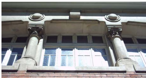
Figura 136 – Sede da Sociedade Nacional de Belas Artes, Rua Barata Salgueiro, n.º 36, Lisboa, 1913 – Detalhe dos vãos da fachada principal.
