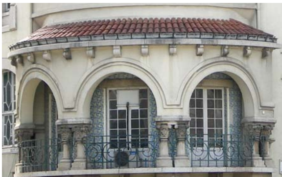
Figura 238 - Guardas em ferro forjado, com desenho de referência arte-nova – Pormenor do Alçado do edifício do Colégio Académico, Avenida da Republica, n.º 13. Lisboa.
