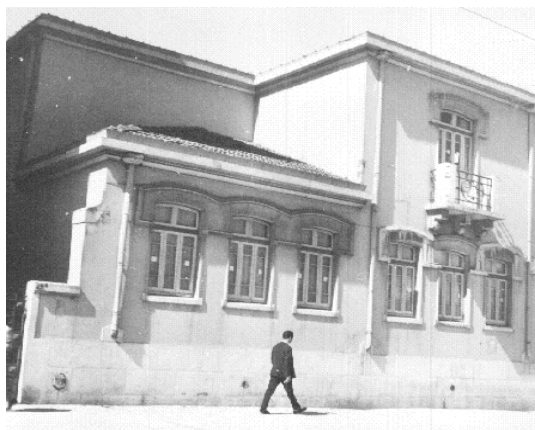
Figura 75 – Casa da Sr.ª D. Olympia de Macedo Branco, no Gaveto da Avenida Ressaio Garcia com a Visconde de Valmor, Lisboa, 1905. [AFCML]
