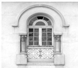
Figura 237 - Arco de volta perfeita assente em colunas embebidas – Pormenor do Alçado do edifício do Colégio Académico, Avenida da Republica, n.º 13.
