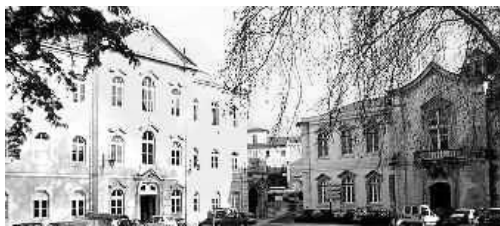
Figura 168 - Aspecto actual das fachadas principais dos edifícios do complexo do Hospital Termal.
