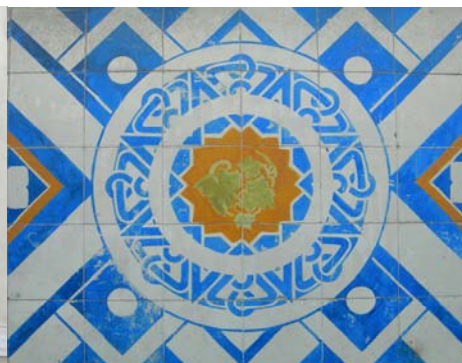
Figura 239 - Painel de azulejo existente na fachada do edifício do Colégio Académico, Avenida da Republica, n.º 13. Lisboa.
