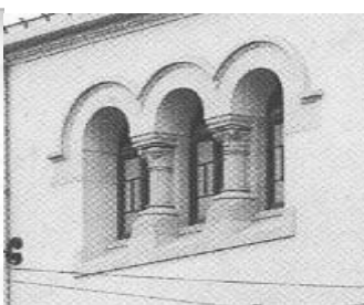
Figura 236 - Janelas tripartidas – Pormenor do Alçado do edifício do Colégio Académico, Avenida da Republica, n.º 13.
