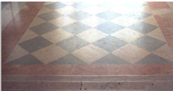
Figura 130 – Sede da Sociedade Nacional de Belas Artes, Rua Barata Salgueiro, n.º 36, Lisboa, 1913 – Detalhe da estereotomia do pavimento do átrio de entrada pela Rua Barata Salgueiro.
