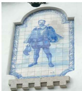
Figura 266 - Paineis de azulejo existente num nicho no edifício do Museu Bordalo Pinheiro, Campo Grande, n.º 382. Lisboa.
