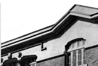
Figura 235 - Linha de frontão quebrada em prolongamento horizontal – Pormenor do Alçado principal do edifício do Sede da Sociedade Nacional de Belas Artes, Rua Barata Salgueiro, n.º 36.
