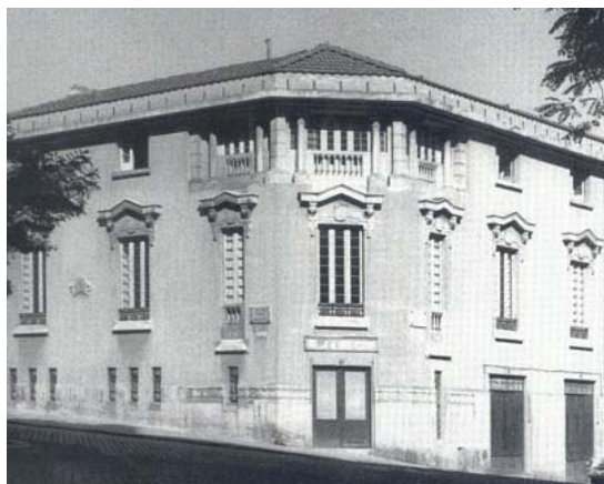
Figura 149 – Palacete do Sr. Dr. Alfredo May de Oliveira, no Gaveto da Avenida Duque de Loulé, nº 47, com a Rua Bernardo Lima, Lisboa, 1919. [AFCML]
