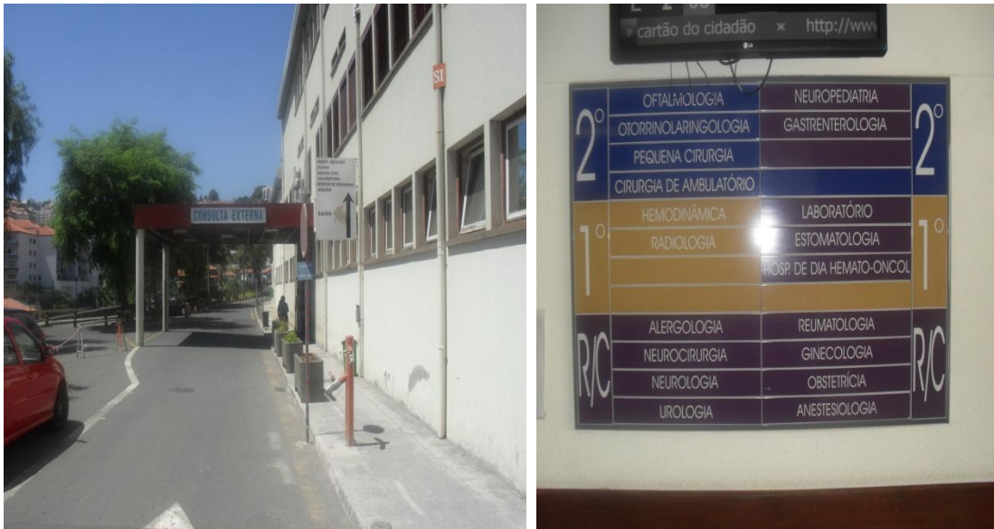
Figura 6 – Edifício Antigo da Consulta Externa do HNM e as suas Especialidades Médicas Fonte: HNM
