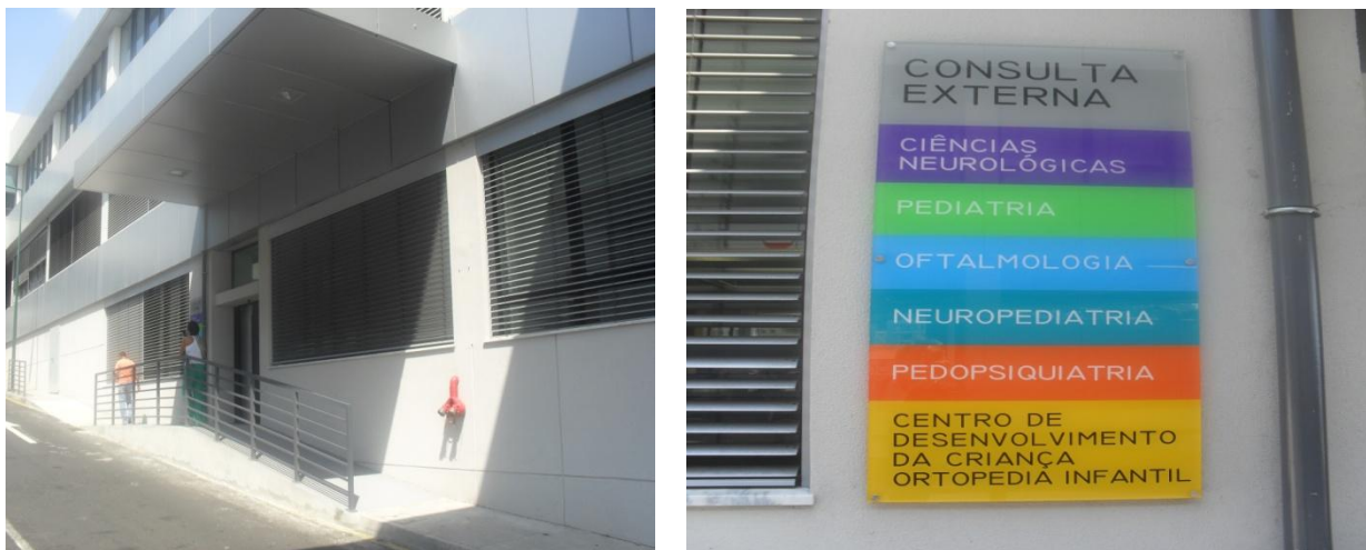
Figura 5: Novo Edifício da Consulta Externa do HNM e as suas Especialidades Médicas
