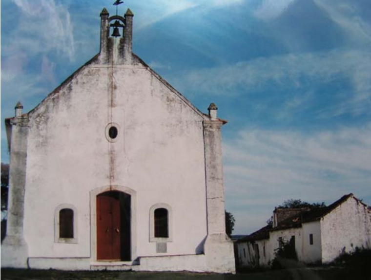
Estado actual da capela.
