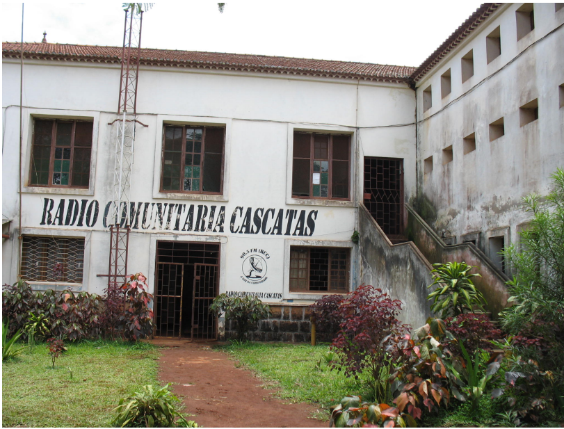
Figura 44: Edifício da Rádio Cascatas, Namacha, 2009.
