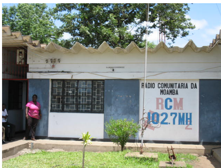
Figura 58: Instalações do CMC da Moamba, Maputo, 2009.
