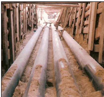
Figura 2 – Construção da rede distribuição da CLIMAESPAÇO (Fonte: CLIMAESPAÇO)
