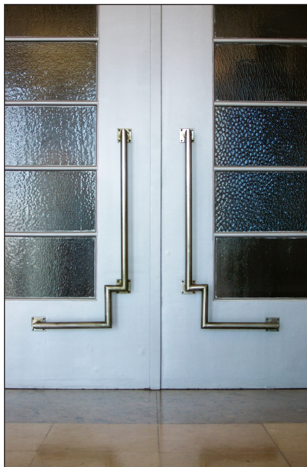
Acesso ao hall do pavilhão central. Foto: Tatiana Soares, 2011
