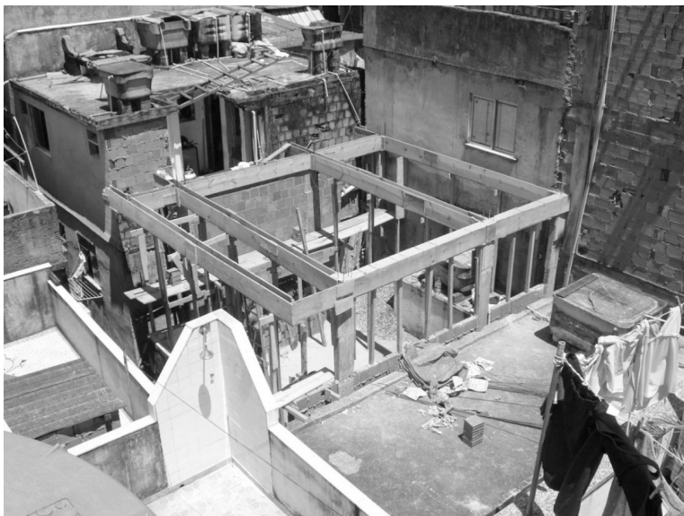
Figura 7.13 A escola durante a obra
