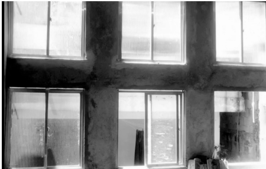
Figura 7.14 Sala do terceiro piso durante a obra
