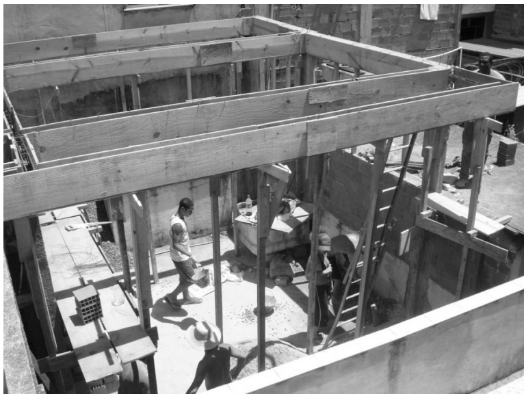
Figura 7.11 Escola da Rocinha durante a construção
