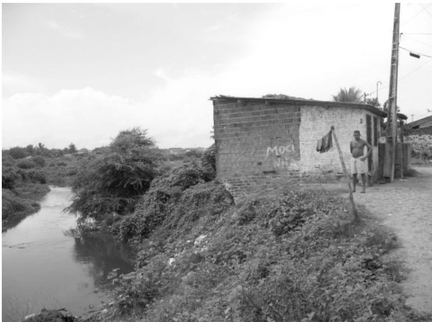
**Figura 4.5** Casa prestes a ruir em virtude da erosão da margem do rio
