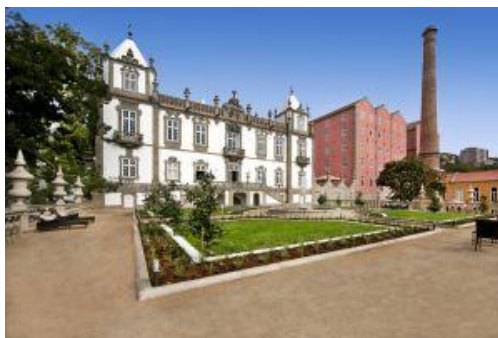
Imagem 13: Fachada e Jardim – Pousada do Porto – Palácio do Freixo
