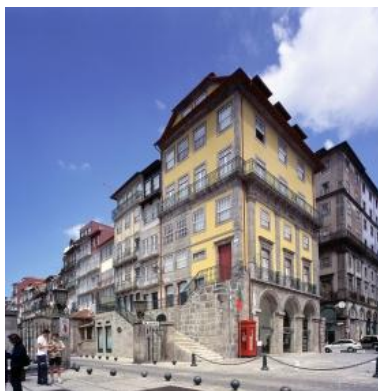
Imagem 8: Fachada – Pestana Porto Hotel
