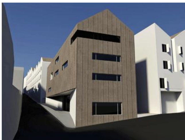
Imagem 50: Fachada – CS Vintage Oporto Hotel
