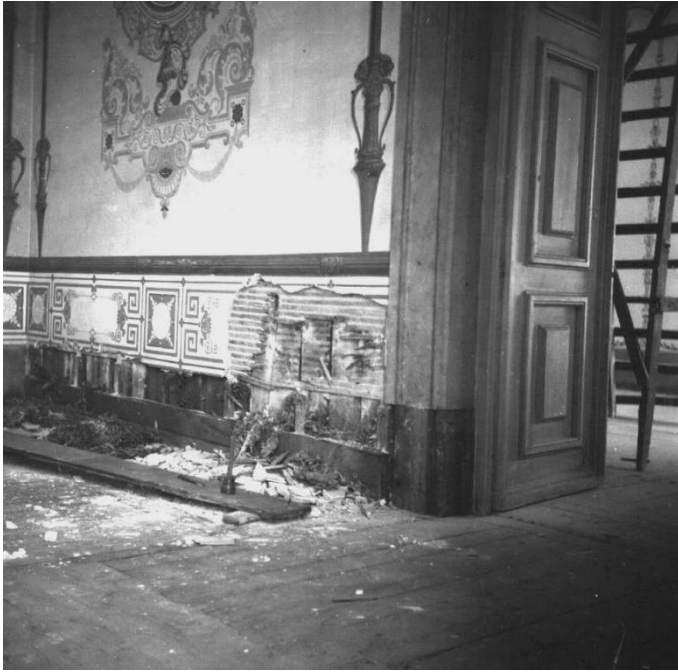
Aposentos Torreão Sul - início da demolição do tabique (Arquivo IHRU: DGEMN, 139-1293)
