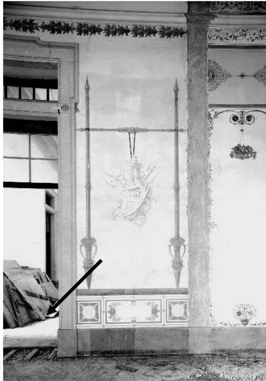
Aposentos Torreão Sul - Pormenor do pavimento (Arquivo IHRU: DGEMN, 139-467)
