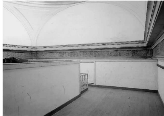
Divisões vistas de cima, sobre o tecto (Arquivo IHRU: DGEMN, 139-390)
