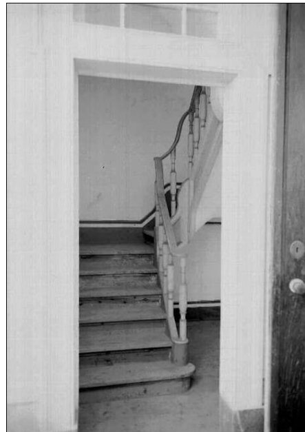
Escadas interiores, torreão sul (Arquivo IHRU: DGEMN, 139-391)
