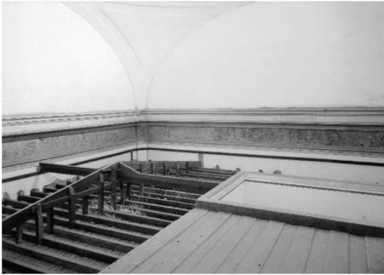
Divisões vistas de cima, sobre o tecto (Arquivo IHRU: DGEMN, 139-389)
