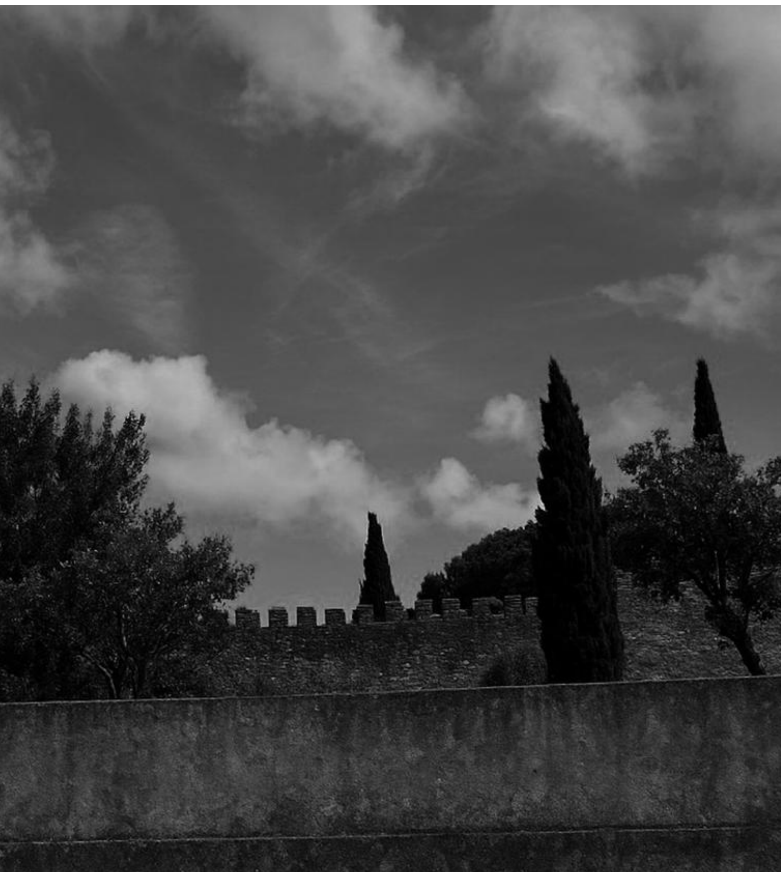
Vista do local de intervenção para a torre e a muralha
