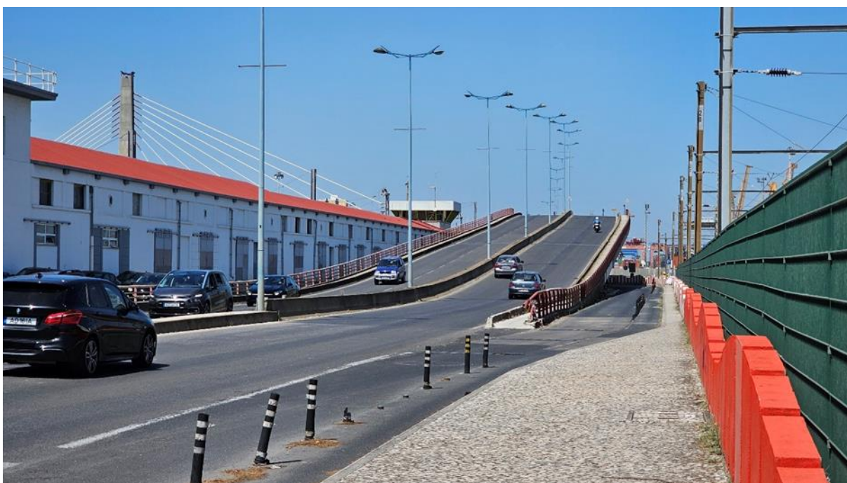
Figura 15 – Registo fotográfico antes do viaduto de Santos-o-Novo. Olhando para Norte.
