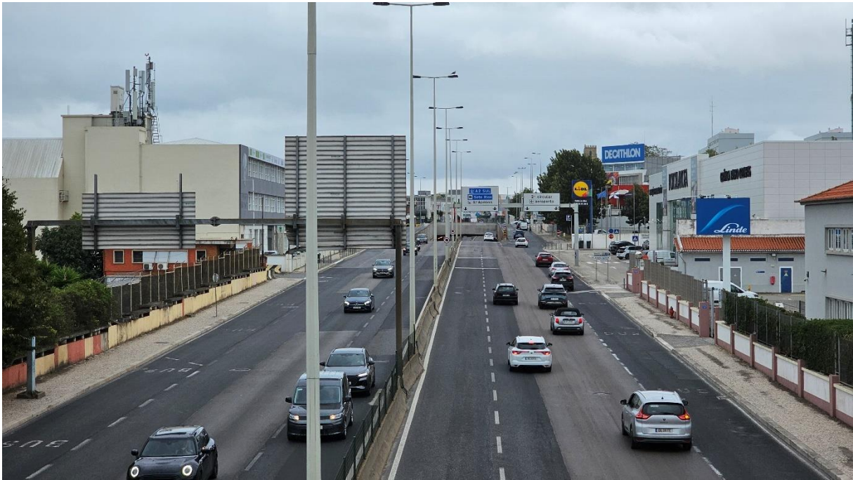
Figura 12 – Registo fotográfico da Av. Infante D. Henrique, a partir da ponte pedonal, dentro da área de estudo. Olhando para Sul.
