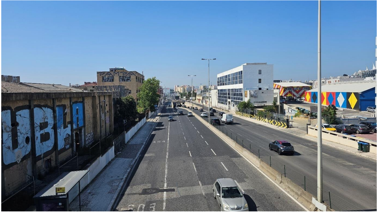
Figura 67 – Registo fotográfico da avenida do viaduto pedonal existente.
