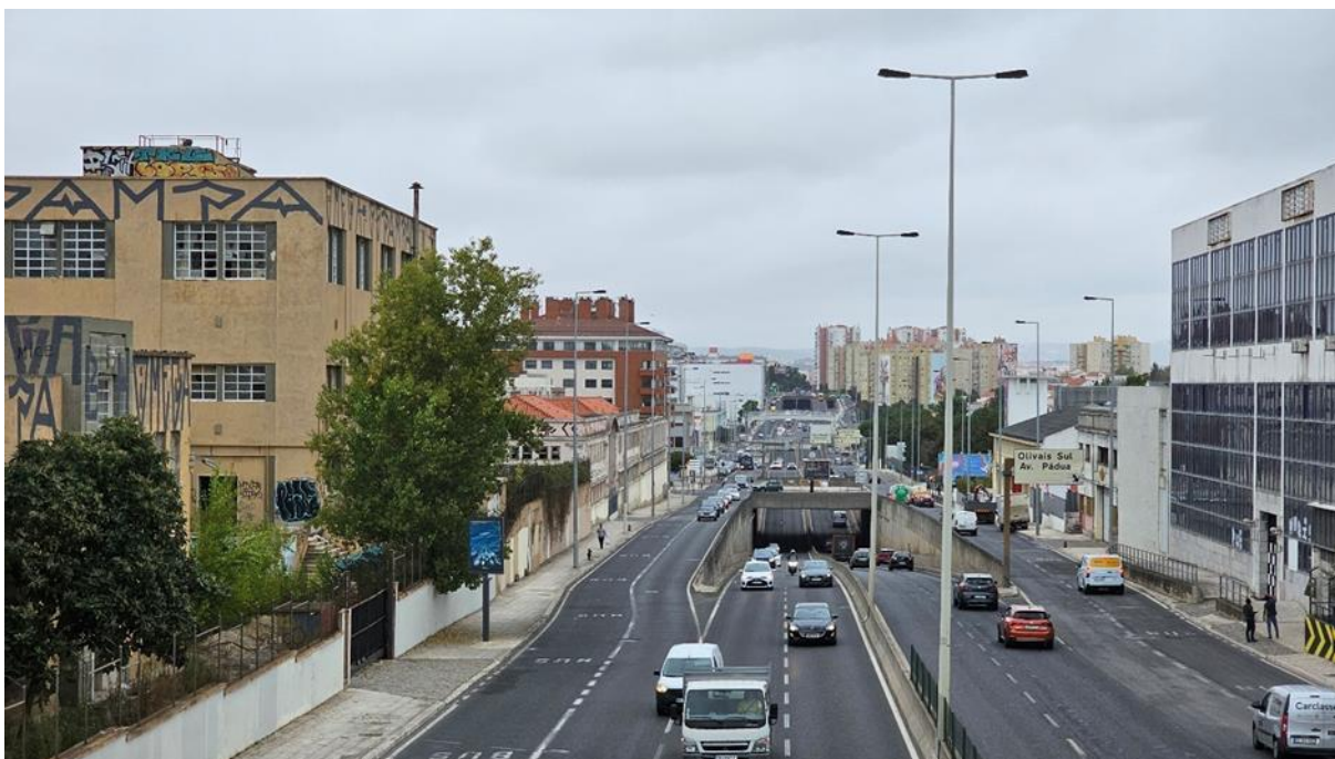
Figura 13 – Registo fotográfico da Av. Infante D. Henrique, a partir da ponte pedonal, dentro da área de estudo. Olhando para Norte.
