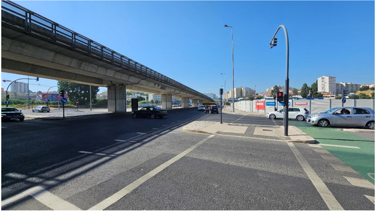
Figura 76 – Registo fotográfico da avenida, por baixo do viaduto elevado.
