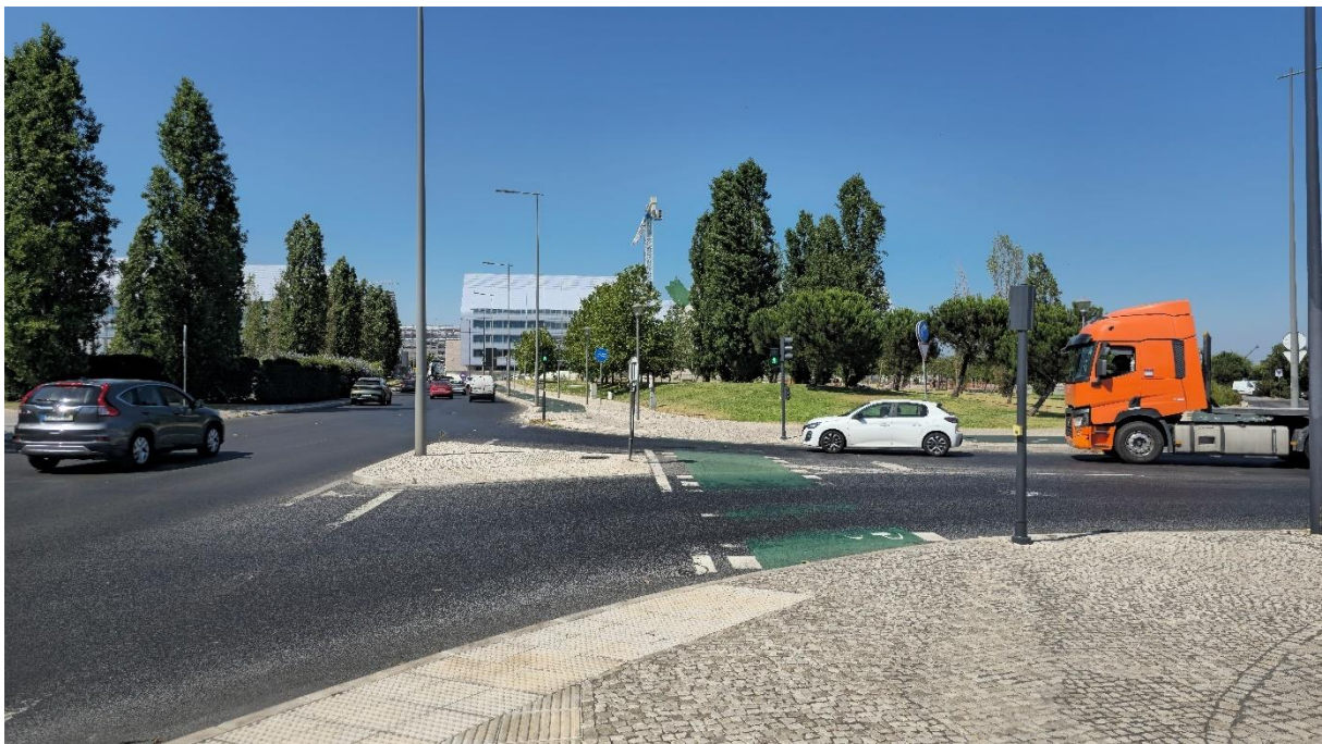
Figura 58 – Registo fotográfico da avenida na zona da futura estação do Parque Ribeirinho Oriente.
