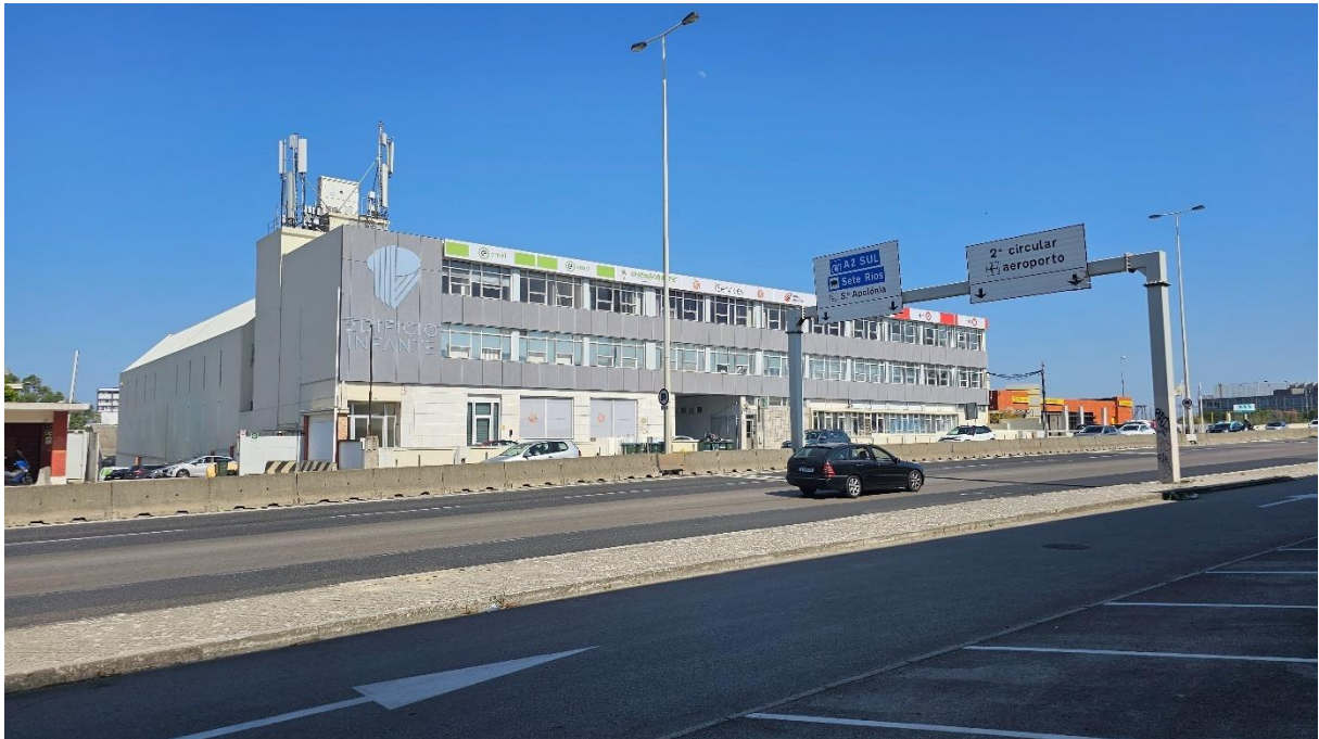
Figura 70 – Registo fotográfico da avenida. Edificado em utilização.
