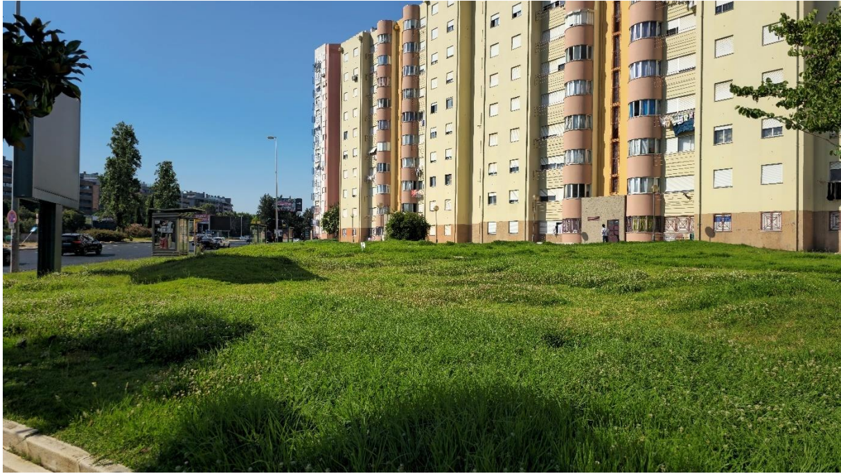
Figura 80 – Registo fotográfico da avenida, na zona da futura estação terminal de Moscavide.
