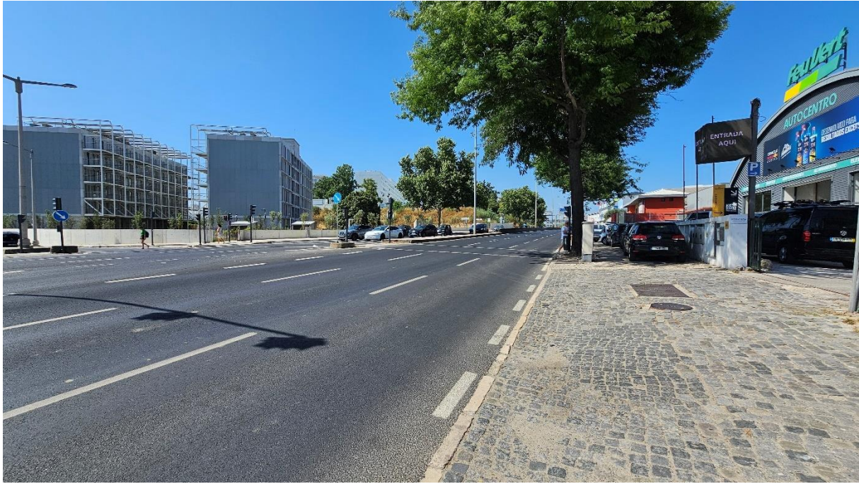
Figura 61 – Registo fotográfico da avenida na zona da futura estação de Vale Fundão.
