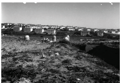
Figura 6 - Construção do Bairro da Encarnação. s.d. Arquivo Municipal de Lisboa, ref. PT-AMLSB-CMLSBAH-PCSP-004-JBN-005101.
