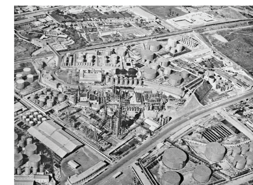
Figura 25. Vista aérea sobre o complexo industrial da SACOR, SD NI
