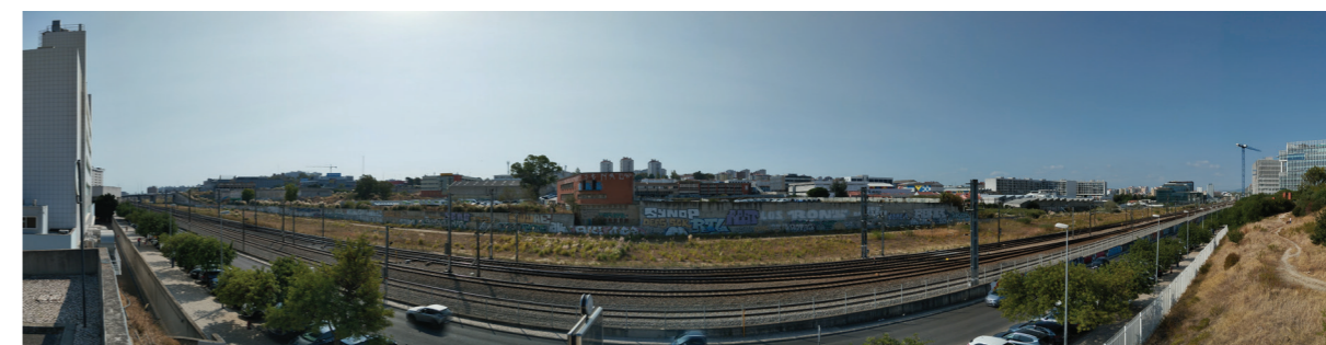
Figura 23. Linha de Comboio - Barreira
