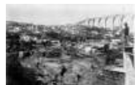
70N. Obras de encanamento da Ribeira de Alcântara, fotografia retirada a partir do viaduto de Santana ©Camãra Municipal de Lisboa
