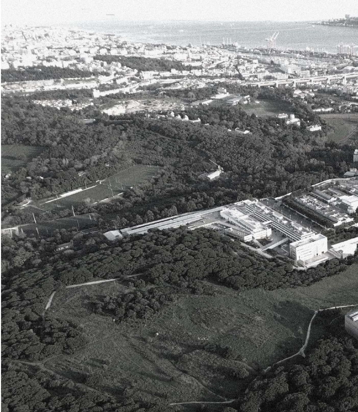
744. Vista sobre o Vale do Rio Seco e implantação do Projeto.
