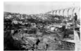
70N. Obras de encanamento da Ribeira de Alcântara, fotografia retirada a partir do viaduto de Santana ©Camãra Municipal de Lisboa.
