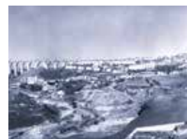
74N. Infraestruturas: Aqueduto. © Autor Desconhecido.
