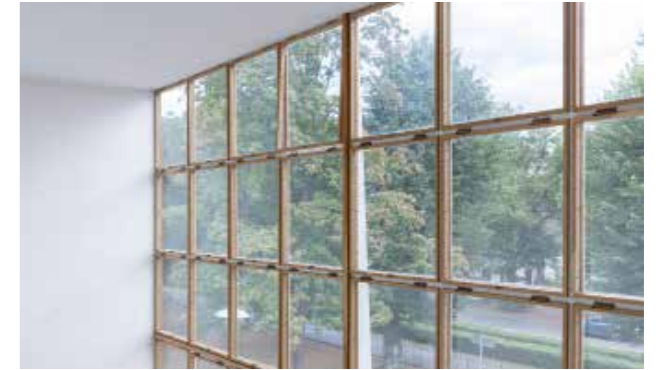
Figura 68 - Detalhe da fachada de vidro a este do edifício. © Jussi Toinaven
