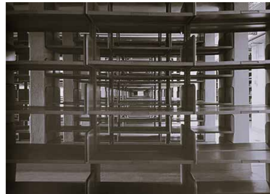
Figura 89 - Vistas da estanteria cujas ilhargas são os pilares da estrutura do depósito de livros.
