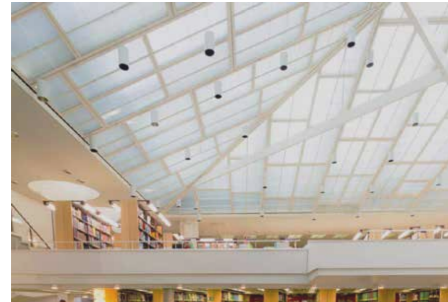
Figura 136 - Claraboia piramidal sobre uma das varandas da sala de leitura. ©Biblioteca Estatal de Berlim
