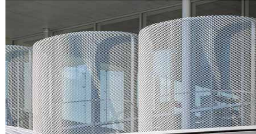
Figura 387 - Pormenor das chapas metálicas na fachada norte. © Vincent Hecht
