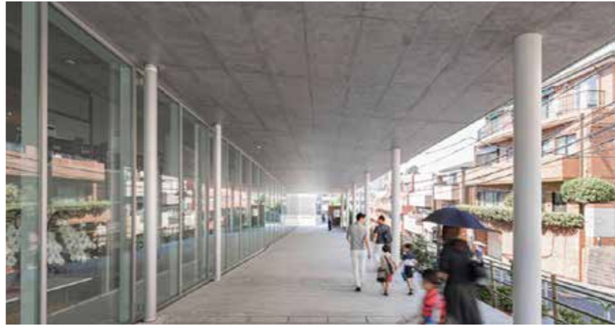
Figura 376 - Rampa do lado oeste da biblioteca. © Vincent Hecht
