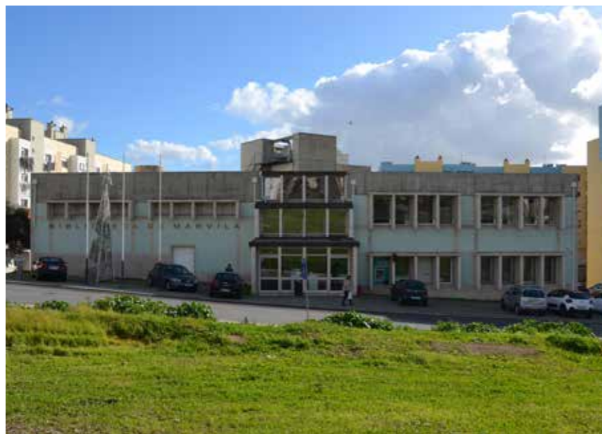
Figura 300 - Fotografia da fachada principal. © Vera Morais
