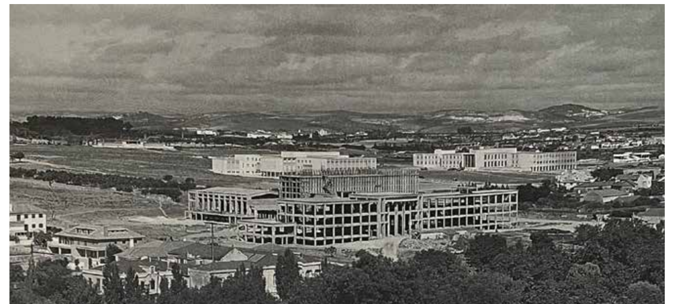
Figura 91 - Vista geral da estrutura.
