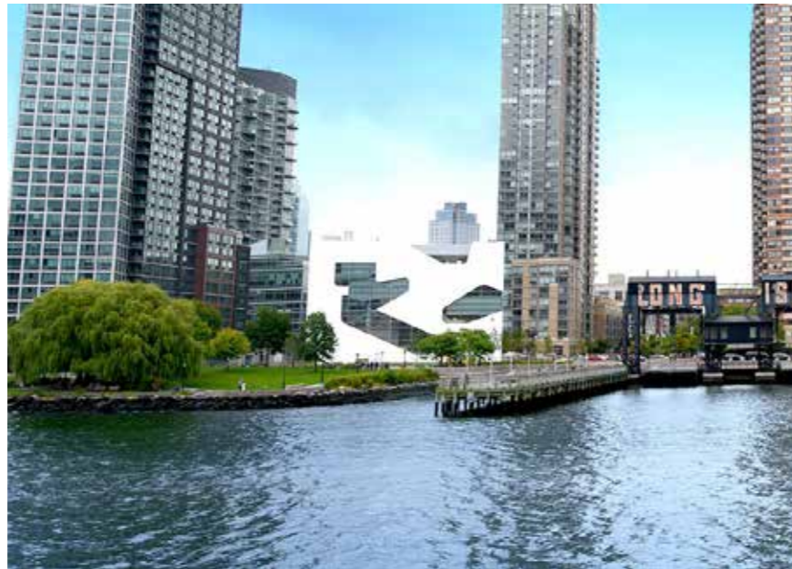
Figura 356 - Fotografia da fachada poente da biblioteca.
