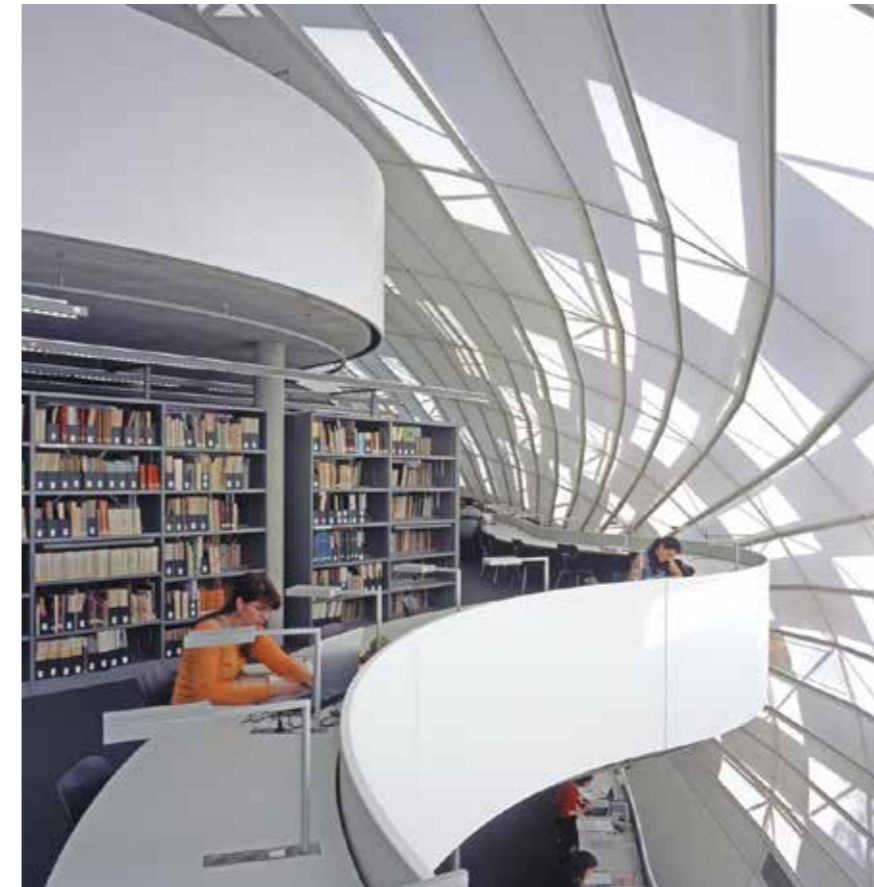
Figura 238 - Fotografia que mostra a relação espacial entre os diferentes pisos e a cobertura como estrutura autónoma do projeto. © Reinhard Gorner
