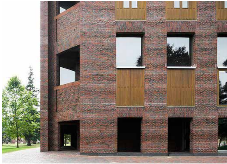
Figura 111 - Fachada com Socos e Vãos. © Inaki Bergera
