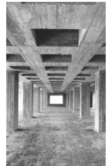
Figura 90 - Estrutura portante do edifício.
