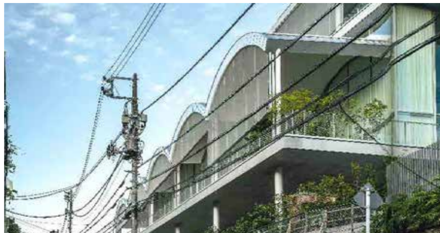
Figura 385 - Fachada oeste. © Hisao Suzuki
