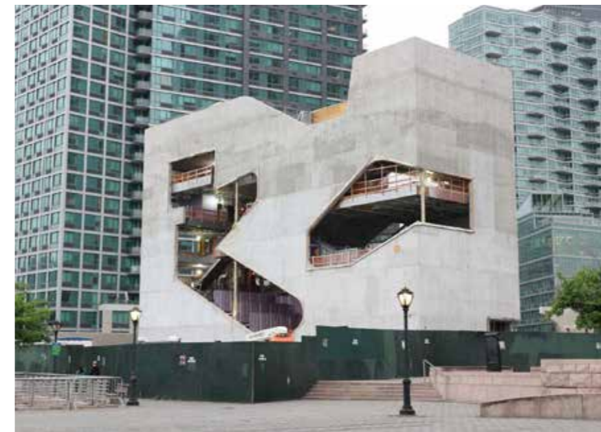
Figura 353 - Fotografia do exterior da biblioteca em construção.
