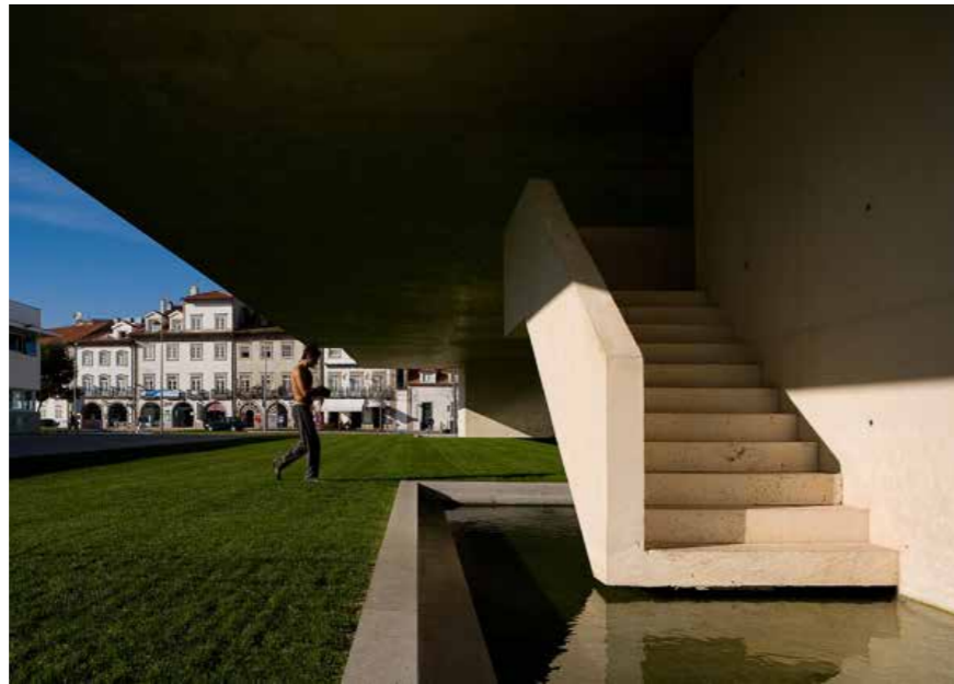
Figura 257 - Escadas de emergência. © Fernando Guerra
