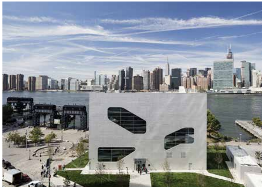
Figura 357 - Fotografia da fachada nascente da biblioteca. © Steven Holl Architects
