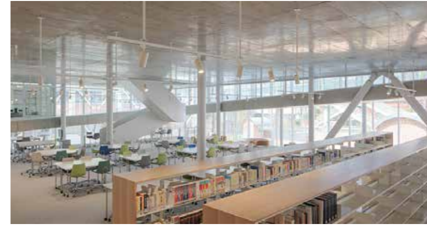
Figura 380 - Vista do piso 1.
