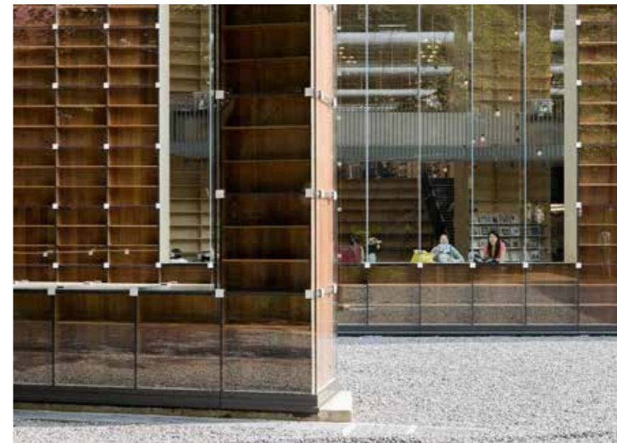
Figura 271 - Vão exterior do foyer. © Iwan Baan
