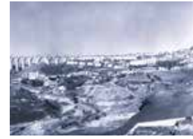
74N. Infraestruturas: Aqueduto. © Autor Desconhecido.
