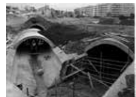
73N. Obras de canalização da ribeira de Alcântara na zona de Benfica, fotografia retirada em 1967 ©Camãra Municipal de Lisboa
