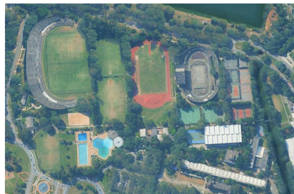
Figura 64– GOOGLE EARTH. Vista aérea do Centro de Práticas Desportivas da USP, São Paulo. Disponível em: https://earth.google.com/web/
