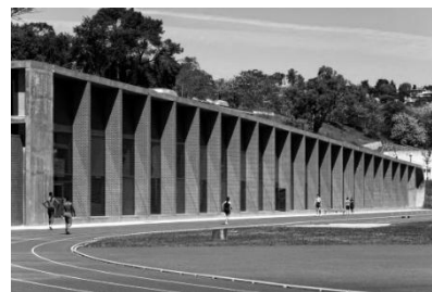
Figura 60 - Pista de atletismo do Centro de alto rendimento do Jamor. Espaço Cidade Arquitetos. Disponível em: url/carJamor_EspacoCidadeArq
