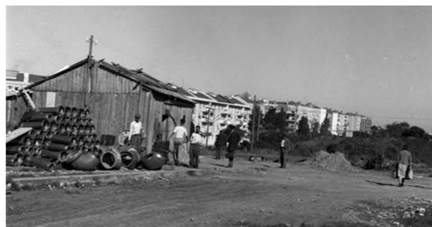
Figura 392 - 2ª Circular em construção junto à linha férrea, 1961.
