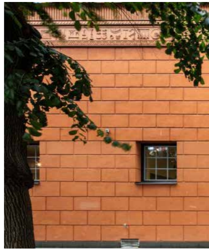
Figura 33 - Pormenor da fachada. © Frederico Covre Figura 34 - Escadarias do interior. © Frederico Covre
