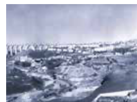
74N. Infraestruturas: Aqueduto. © Autor Desconhecido.
