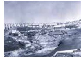
74N. Infraestruturas: Aqueduto. © Autor Desconhecido.
