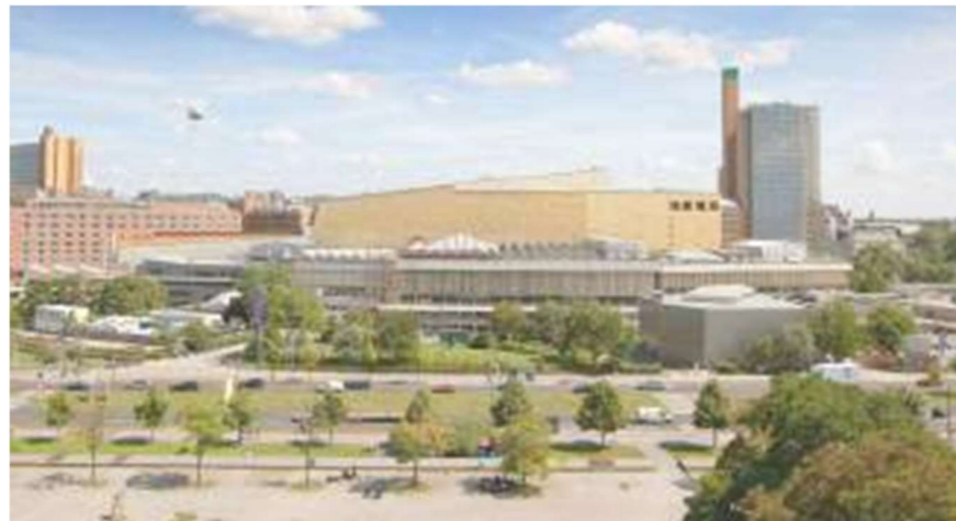
Figura 120 - Fachada principal. ©Da flow
