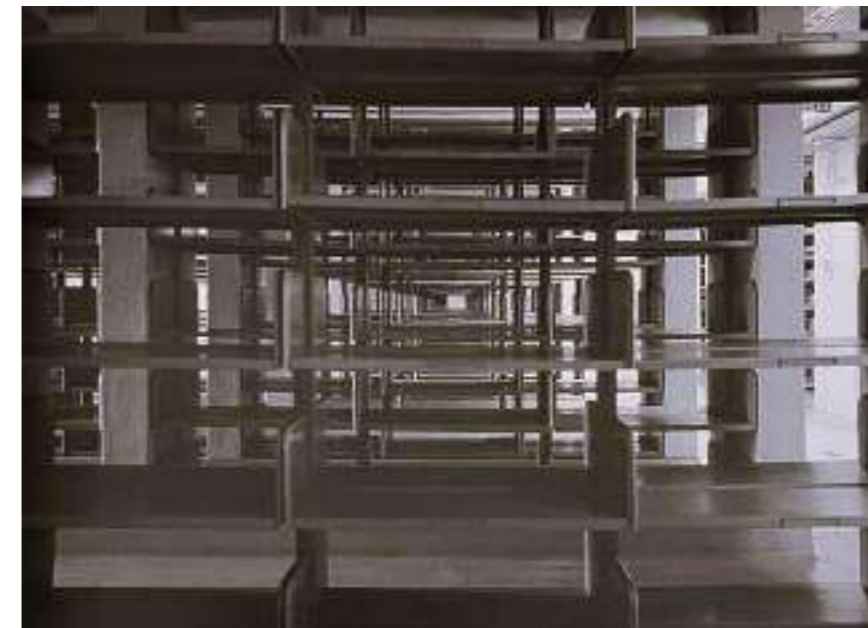
Figura 89 - Vistas da estanteria cujas ilhargas são os pilares da estrutura do depósito de livros.
