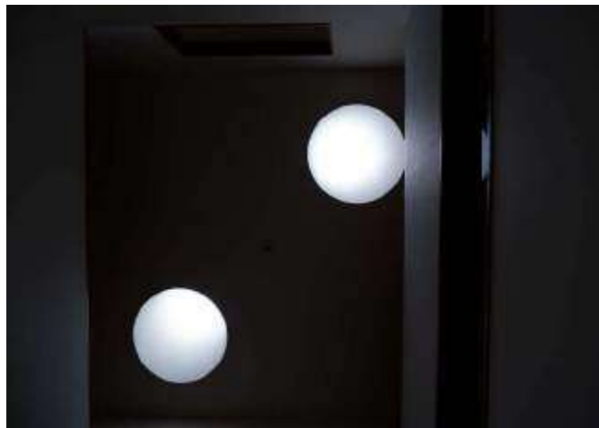
Figura 195 - Vista interior dos lanternins. © Maria do Mar Rafael
