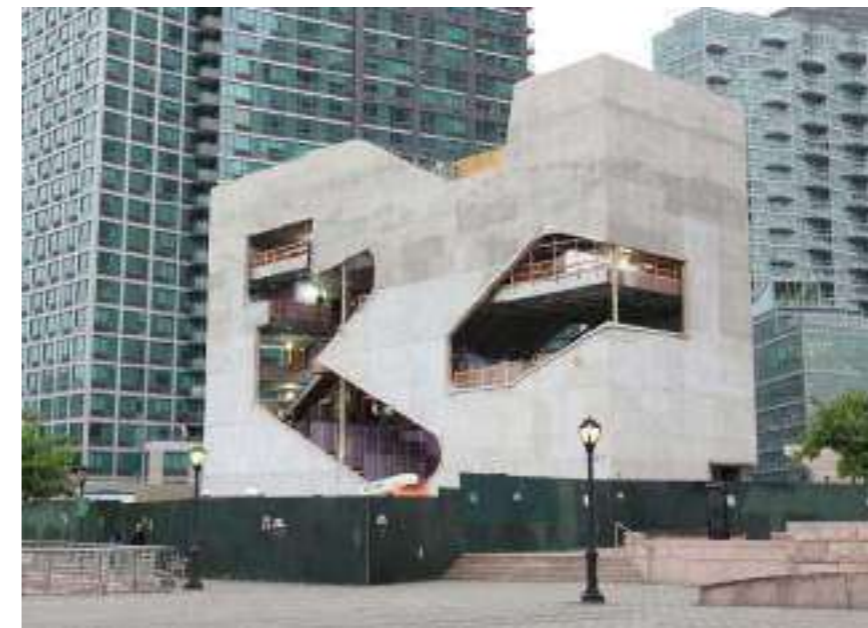
Figura 353 - Fotografia do exterior da biblioteca em construção.
