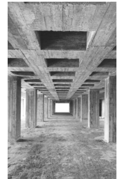
Figura 90 - Estrutura portante do edifício.
