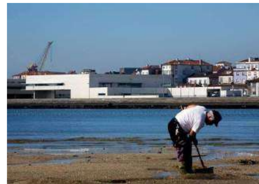
Figura 249 - Vista sobre o edifício através da margem Sul do Rio Lima. © Fernando Guerra
