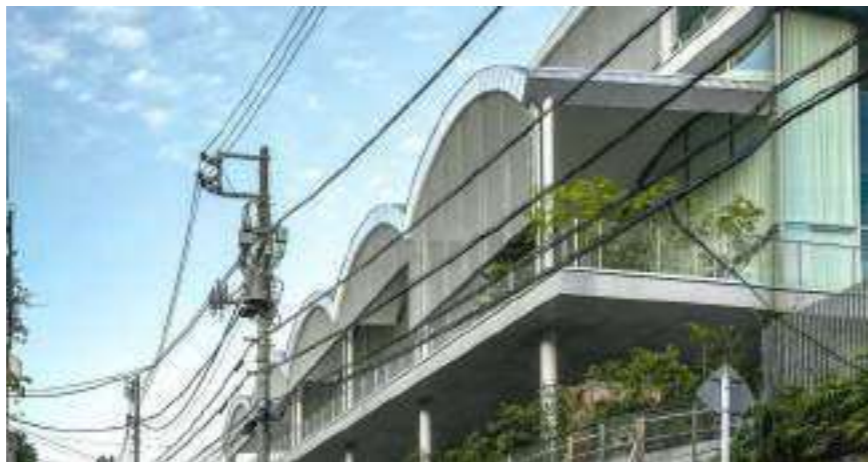
Figura 385 - Fachada oeste. © Hisao Suzuki
