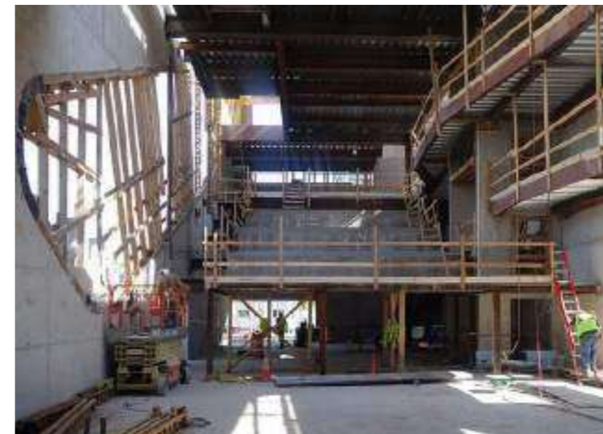
Figura 354 - Fotografia do interior da biblioteca em construção. © Steven Holl Architects
