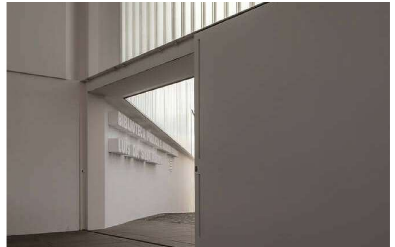
Figura 332 - Detalhe interno da estrutura translúcida e exposição das vigas, destacando a entrada da biblioteca. © Leonardo Finotti
