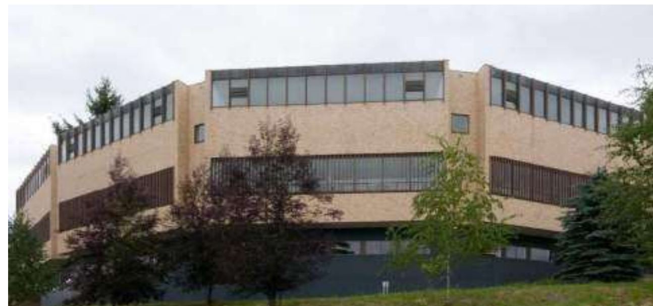
Figura 162 - Fotografia da Fachada Norte. © Michael Dant.
