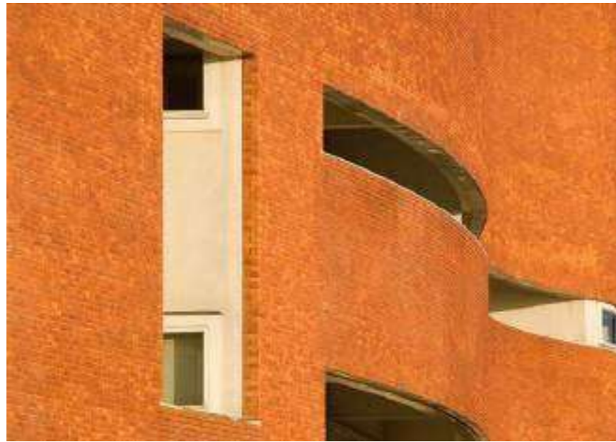
Figura 193 - Vãos na parede curva exterior. © Fernando Guerra
