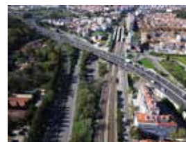
68N. Estação de Benfica. © Rita Ansone. Arquivo Fotográfico.
