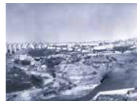
74N. Infraestruturas: Aqueduto. © Autor Desconhecido.
