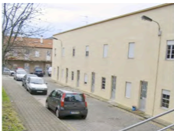
Figura 7. Vista do SAAL Lapa a partir da rua. O pátio como mediador entre I e R. Acesso aos Blocos 01 e 02. Foto: Rafaela Cavalcanti, 2010.
