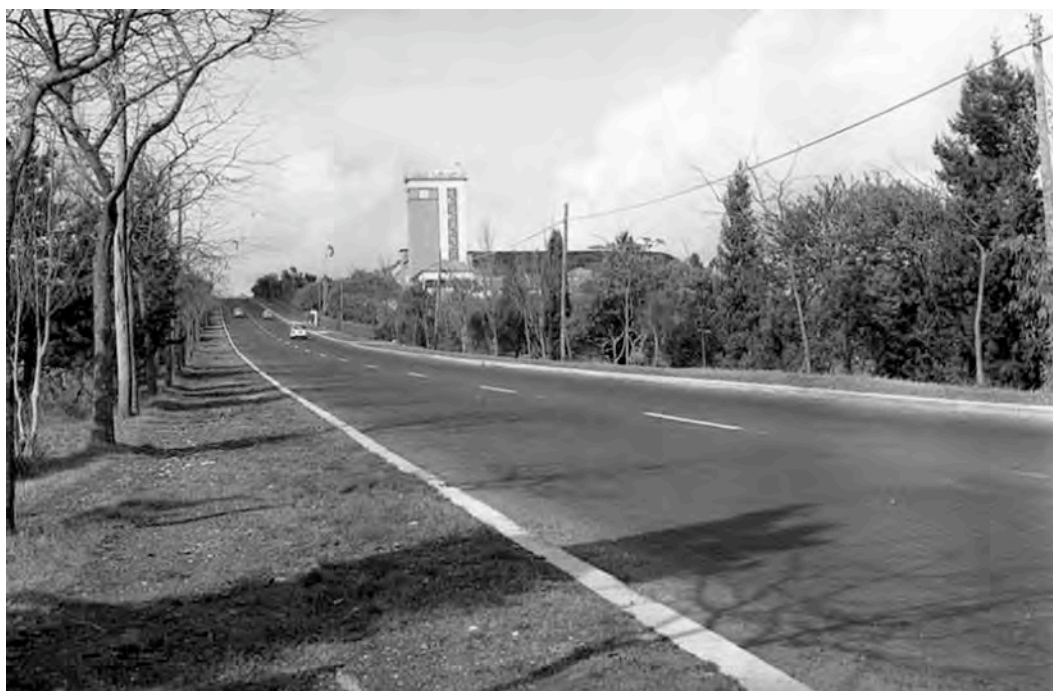
Fig. 1 – Recta dos Cabos d’Avila em 1961, já marcada pela presença da fábrica de condutores eléctricos.
