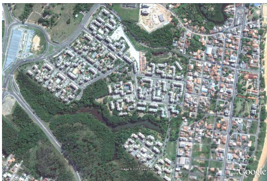
Figura 8. Vista aérea parcial do bairro Conjunto Jacaraípe
