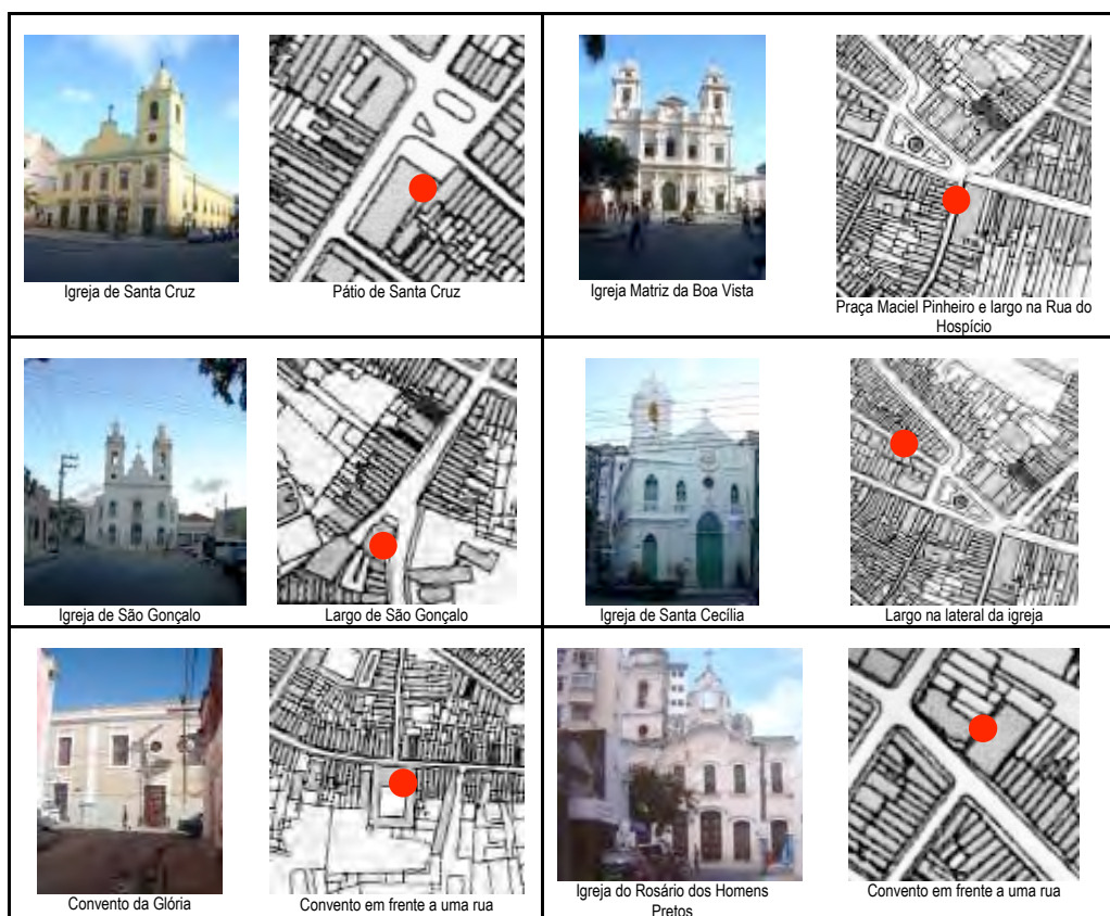
Figura 04: As Igrejas da área estudada, todas edificadas ao longo do século XVIII, localizadas em pontos que as destacam na morfologia do conjunto. Mapa atual da Boa Vista. Fonte: FIDEM - Fotos: Vânia Cavalcanti. Ano: 2007.
