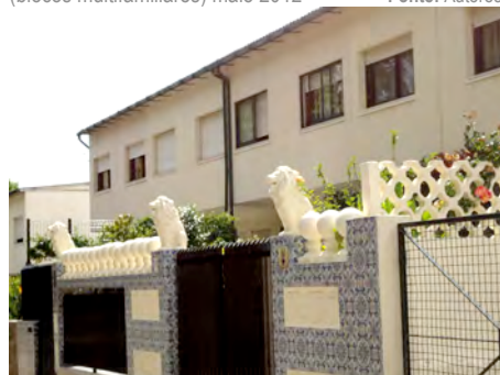
Fotografia 9 Bairro dos Grémio dos Armazenistas (alterações fachadas) maio 2012 Fonte: Autores
