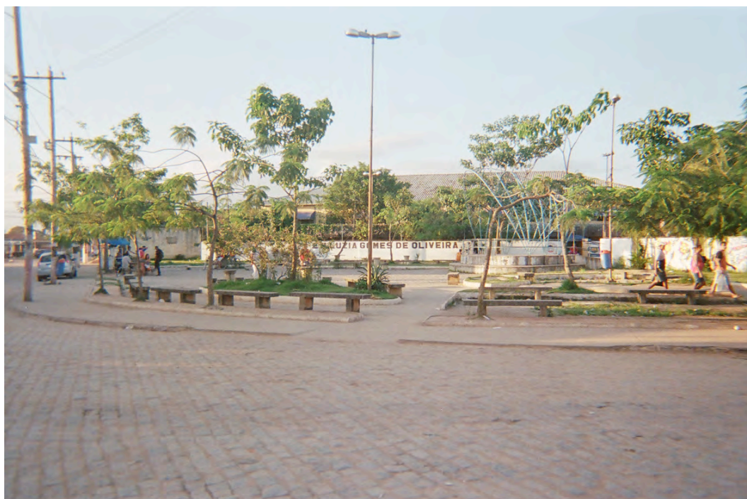
Figura 8: Margem norte da BR-493 Fonte: Arquivo Próprio, 2012.
