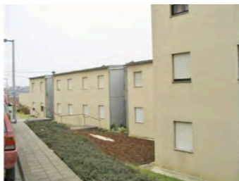
Figura 8. O Bloco 01 SAAL Massarelos a partir da rua central. Aqui, todos os apartamentos são acessados por meio da circulação vertical, diretamente conectada à rua. Foto: Rafaela Cavalcanti, 2010.
