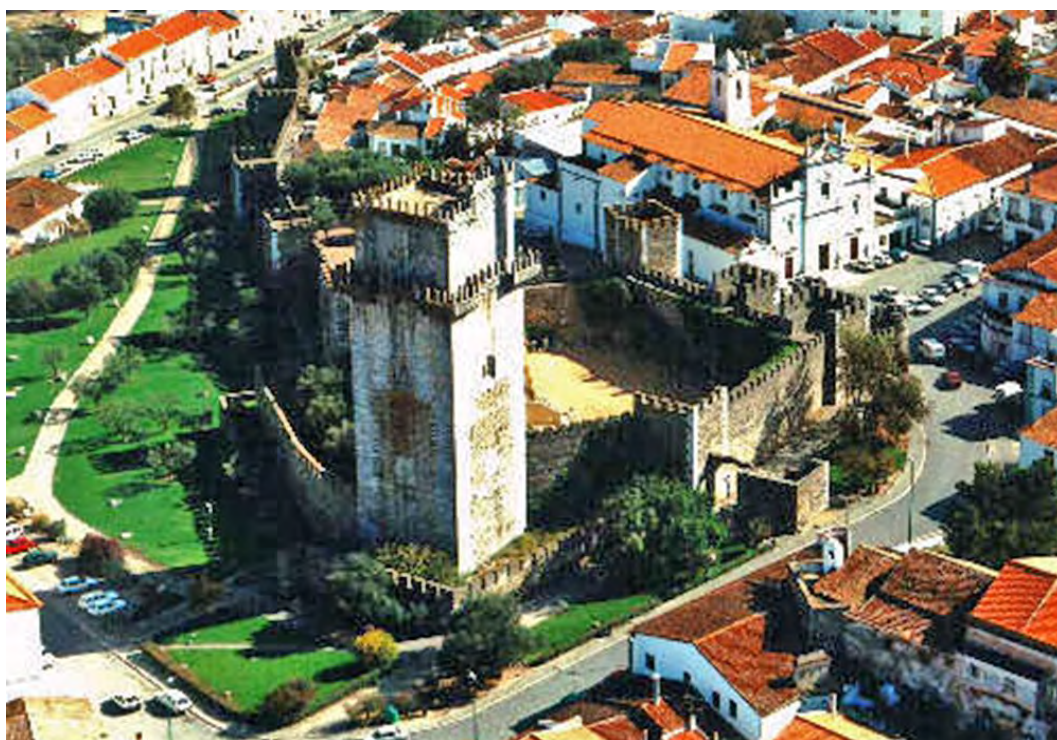
Figura 7. Castelo de Beja, rodeado por um espaço novo parcialmente resultante de demolições (fonte: IHRU - arquivos da DGEMN)
