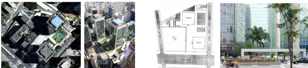
Figuras 14: Edifício Cetenco Plaza, em São Paulo, década de 1980. Fonte: Guerra, 2011
