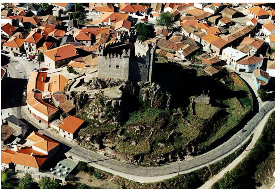
Figura 8. Castelo de Penedono, parcialmente envolvido por um espaço verde de tratamento minimalista (fonte: IHRU - arquivos da DGEMN)
