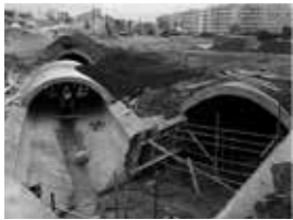
73N. Obras de canalização da ribeira de Alcântara na zona de Benfica, fotografia retirada em 1967 ©Camãra Municipal de Lisboa
