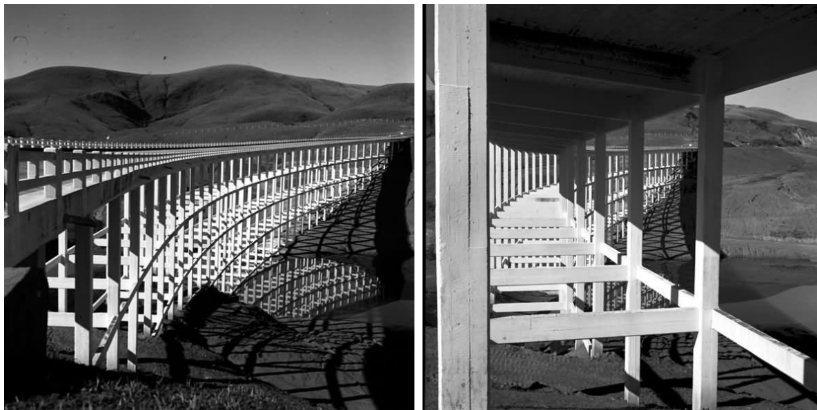
Figura. 2. Viaduto Vila Rica, 1957
