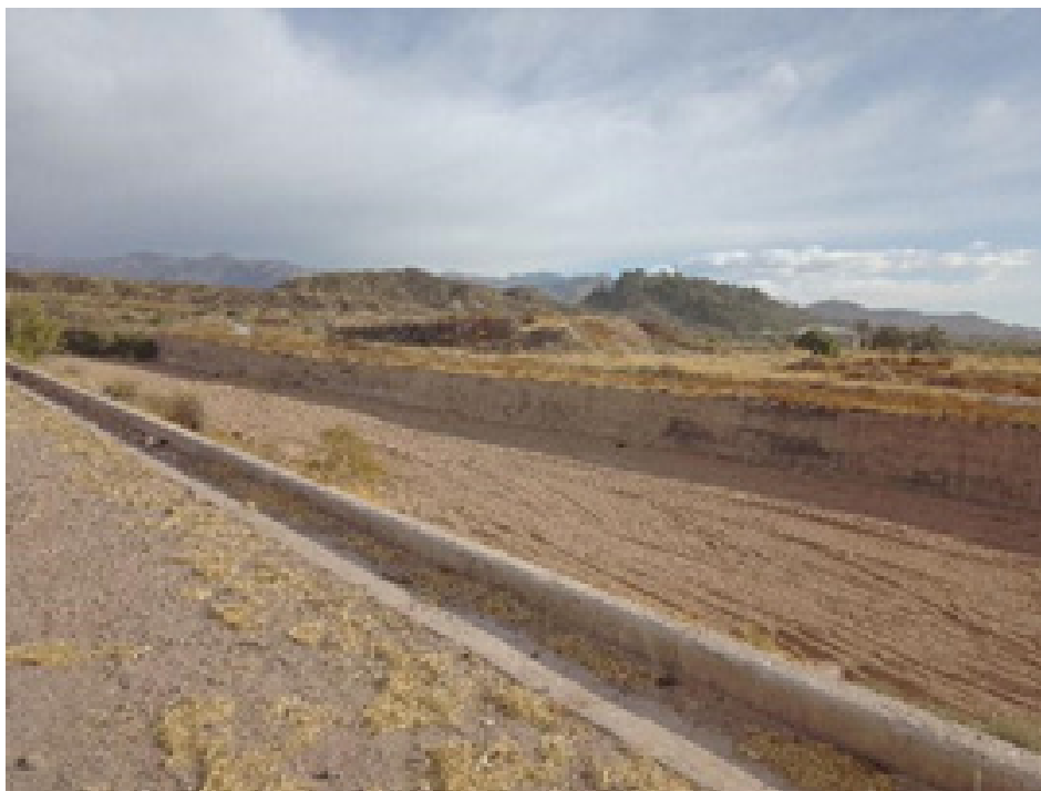
Figura 3. Zanjón Frías. Tramo intermedio canalizado, inserto en la trama urbana
