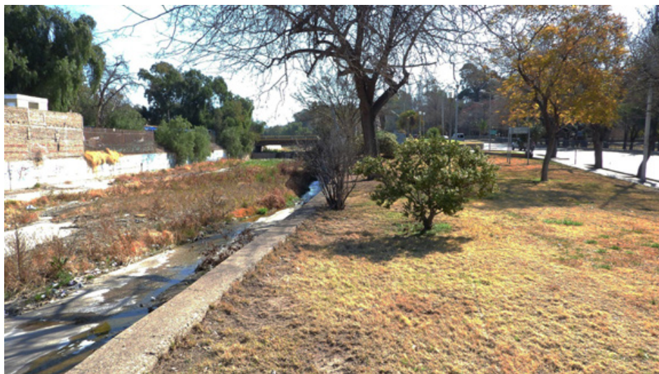
Figura 4. Zanjón Frías. Tramo inferior canalizado, inserto en la trama urbana
